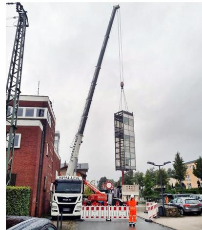
Wir haben die beiden Schachtgerüste mittels Kran zur neuen Überführung gehoben (Oktober 2023) [Quelle: DB Station&Service AG]
