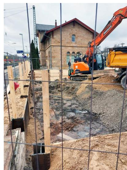
Der Verbau für den Hausbahnsteig wird hergestellt (Februar 2023) [Quelle: DB Station&Service AG]
