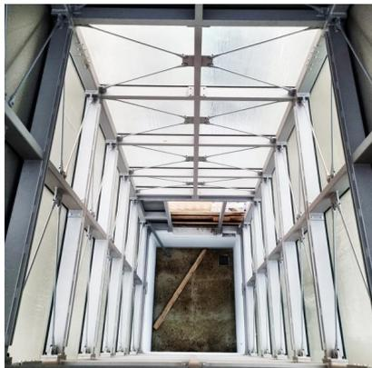
Blick in das eingehobene leere Schachtgerüst für einen der beiden neuen Aufzüge (Oktober 2023) [Quelle: DB Station&Service AG]
