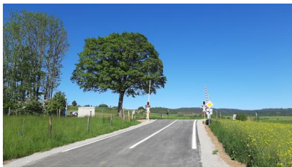
Bis Mai 2021 wurden mehrere Bahnübergänge im Ortsteil Gittelde der Gemeinde Bad Grund (Harz) bereits wieder in Betrieb genommen (Mai 2021) [Quelle: DB Netz AG]
