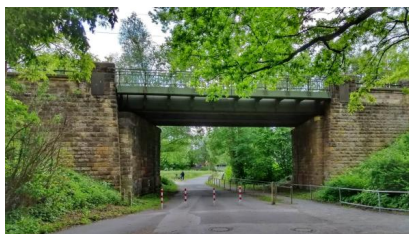
Blick auf die Eisenbahnüberführung (Mai 2019) [Quelle: DB Netz AG]
