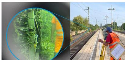
Im August 2022 fanden an der Eisenbahnüberführung „Bismarckstraße“ Vermessungen statt, um die Streckenpläne zu digitalisieren und zu aktualisieren. Die Messungen wurden mithilfe eines Tachymeters (rechts im Bild) durchgeführt. Dieses dient der schnellen Auf- und Einmessungen von bestimmten Punkten. Die Ergebnisse der Vermessung fließen in die digitale 3D-Planung (Building Information Modeling) für die Brücken ein (August 2022) [Quelle: DB Netz AG/Armin Skierlo]
