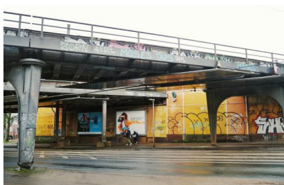
Die Eisenbahnüberführung aus dem Jahr 1912 wird erneuert (Februar 2022) [Quelle: DB Netz AG/Lara-Tanita Rust]
