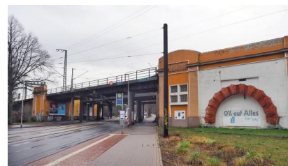
Im Zusammenhang mit der Erneuerung werden die „Hainholzhalle“ (ehemals „Bahnhofshalle“) sowie die Bahnsteige und Treppenaufgänge des Bahnhofs Hainholz zurückgebaut (Februar 2022) [Quelle: DB Netz AG/Lara-Tanita Rust]
