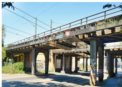
Blick auf die bestehende Eisenbahnüberführung (August 2022) [Quelle: DB Netz AG]
