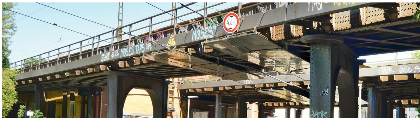
Blick auf die bestehende Eisenbahnüberführung (August 2022) [Quelle: DB Netz AG]
