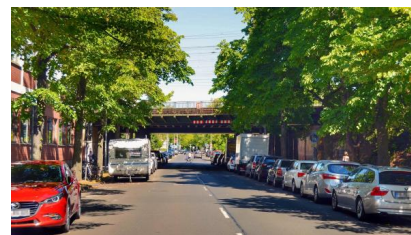
Das südliche Brückenportal im Schatten der Straßenbäume (August 2022) [Quelle: DB Netz AG/Valerie Chilla]
