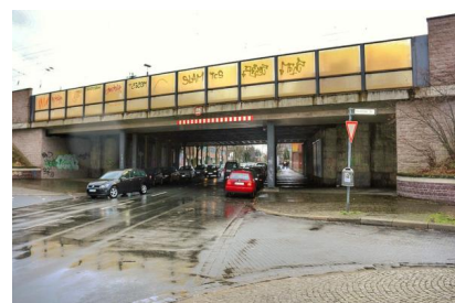
Das Nordportal mit dem Stahlbetonüberbau aus dem Jahr 2000 für die S-Bahn von/nach Celle ist von dem Bauvorhaben nicht betroffen (März 2015) [Quelle: DB Netz AG/Matthias Michaelis]
