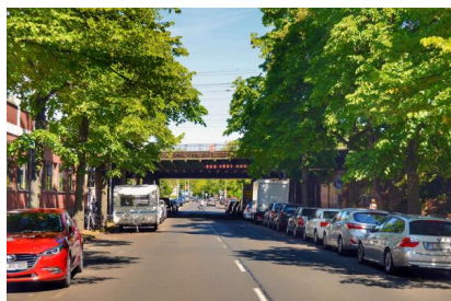
Das südliche Brückenportal im Schatten der Straßenbäume (August 2022) [Quelle: DB Netz AG/Valeria Chilla]
