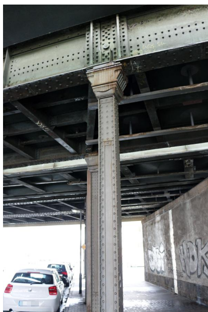
Das Bauwerk entstand 1912/13 und steht seit 1987 unter Denkmalschutz – Genietete Vollwandträger, gusseiserne Stützenreihen, verzierte Widerlager sowie Flügelmauern mit Verkleidungen aus Sandstein zeigen den technischen und gestalterischen Entwicklungsstand im Zeitraum 1912/13 beispielhaft auf (März 2015) [Quelle: DB Netz AG/Matthias Michaelis]
