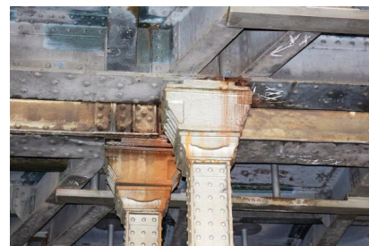
Das Bauwerk entstand 1912/13 und steht seit 1987 unter Denkmalschutz – Genietete Vollwandträger, gusseiserne Stützenreihen, verzierte Widerlager sowie Flügelmauern mit Verkleidungen aus Sandstein zeigen den technischen und gestalterischen Entwicklungsstand im Zeitraum 1912/13 beispielhaft auf (März 2015) [Quelle: DB Netz AG/Matthias Michaelis]
