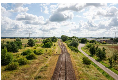
Blick auf die Strecke Richtung Schönhausen (Elbe) (August 2021) [Quelle: DB Netz AG/Jörn Daberkow]
