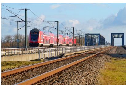
Blick auf einen Zug der DB Regio auf der Elbebrücke Hämerten (August 2025) [Quelle: Deutsche Bahn AG/Volker Emersleben]
