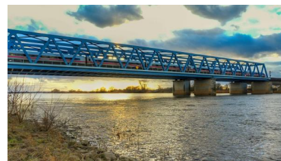
Ein ICE 4 auf der Elbebrücke Hämerten (August 2025) [Quelle: Deutsche Bahn AG/Volker Emersleben]
