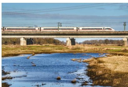
Ein ICE 4 auf der Elbebrücke Hämerten (August 2025) [Quelle: Deutsche Bahn AG/Volker Emersleben]
