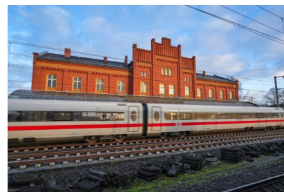
Blick auf den Bahnhof Rathenow (August 2025) [Quelle: Deutsche Bahn AG/Volker Emersleben]
