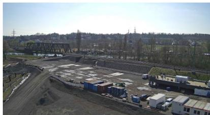
Der Überbau wird parallel neben dem Bahndamm hergestellt (März 2025) [Quelle: DB InfraGO AG]
