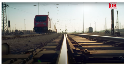
YouTube: Was ist die Korridorsanierung? (Juli 2024) [Quelle: Deutsche Bahn AG]
