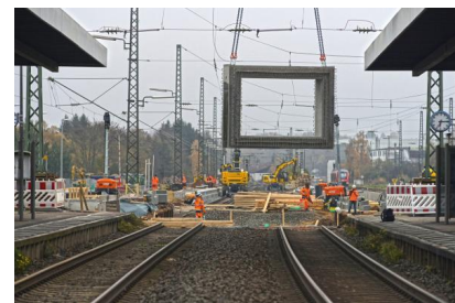
Einhub der Fertigteile der neuen Personenunterführung während des barrierefreien Ausbaus (November 2025) [Quelle: Deutsche Bahn AG/Christian Bedeschinski]
