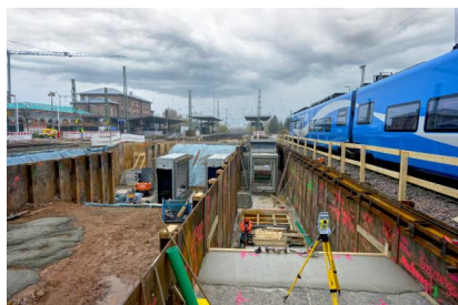
Die Errichtung der neuen Personenunterführung während des barrierefreien Ausbaus (November 2025) [Quelle: Deutsche Bahn AG/Christian Bedeschinski]
