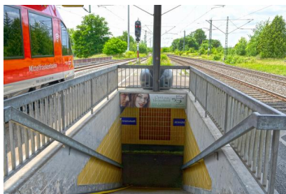
Blick auf den Treppenaufgang am Bahnsteig 2/3 (Juni 2025) [Quelle: DB InfraGO AG/Christian Bedeschinski]
