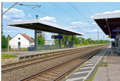
Blick auf den Mittelbahnsteig 4/5 (Juni 2025) [Quelle: DB InfraGO AG/Christian Bedeschinski]
