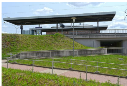
Blick auf den Nordzugang zur Personenunterführung (Juni 2025) [Quelle: DB InfraGO AG/Christian Bedeschinski]
