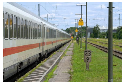
Blick auf Bahnsteig 3 mit durchfahrendem Intercity (Juni 2025) [Quelle: DB InfraGO AG/Christian Bedeschinski]
