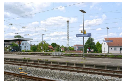
Blick auf die Mittelbahnsteige 2/3 und 4/5 (Juni 2025) [Quelle: DB InfraGO AG/Christian Bedeschinski]
