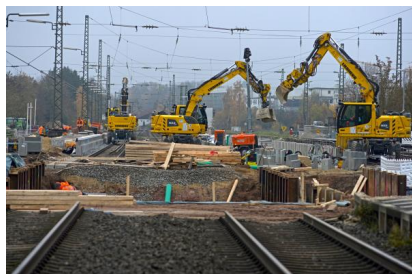
Blick auf die stattfindenden Umbauarbeiten (November 2025) [Quelle: Deutsche Bahn AG/Christian Bedeschinski]
