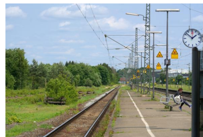
Blick auf den Bahnsteig 5 (Juni 2025) [Quelle: DB InfraGO AG/Christian Bedeschinski]
