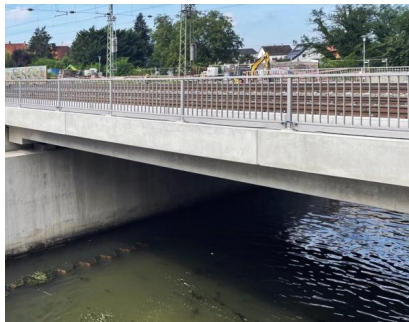
Das neue Brückenbauwerk über den Saalbachkanal nach dem Einbau (August 2024) [Quelle: Lang/KMS]
