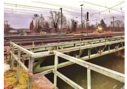
Die Eisenbahnbrücke in Graben-Neudorf erreicht das Ende ihrer Nutzungsdauer und wird daher durch einen Neubau ersetzt (Dezember 2021) [Quelle: DB Netz AG]
