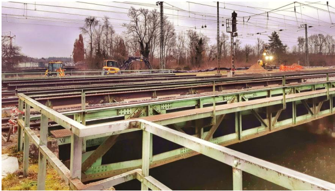
Die Eisenbahnbrücke in Graben-Neudorf erreicht das Ende ihrer Nutzungsdauer und wird daher durch einen Neubau ersetzt (Dezember 2021) [Quelle: DB Netz AG]
