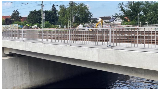
Das neue Brückenbauwerk über den Saalbachkanal nach dem Einbau (August 2024) [Quelle: Lang/KMS]
