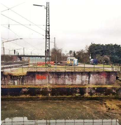
Die Eisenbahnbrücke überführt insgesamt fünf Gleise über den Saalbachkanal (November 2021) [Quelle: DB Netz AG]
