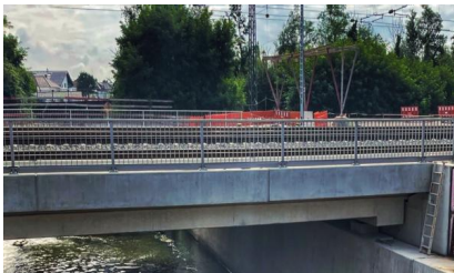
Das neue Brückenbauwerk über den Saalbachkanal nach dem Einbau (August 2024) [Quelle: Lang/KMS]
