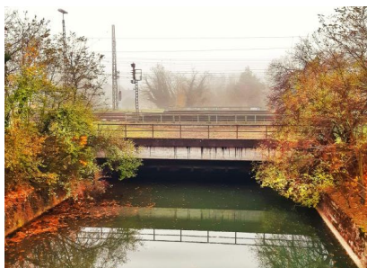
Die Eisenbahnbrücke überführt insgesamt fünf Gleise über den Saalbachkanal (November 2021) [Quelle: DB Netz AG]
