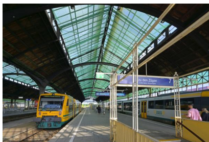
Die Sanierung der Bahnsteighalle wird von Schiff zu Schiff durchgeführt. Voraussichtlich ab März 2023 wird der Gerüstaufbau und die Einhausung der Stahlkonstruktion am Bahnsteig 11/12 beginnen (2021) [Quelle: Deutsche Bahn AG/C. Bedeschinski]
