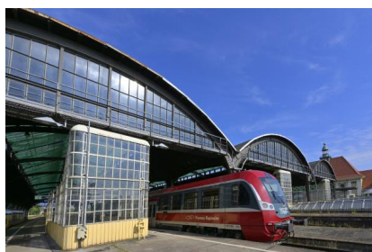
Die Sanierung der Bahnsteighalle wird von Schiff zu Schiff durchgeführt. Voraussichtlich ab März 2023 wird der Gerüstaufbau und die Einhausung der Stahlkonstruktion am Bahnsteig 11/12 beginnen (2021) [Quelle: Deutsche Bahn AG/C. Bedeschninski]
