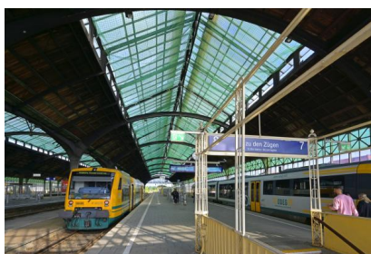
Die Sanierung der Bahnsteighalle wird von Schiff zu Schiff durchgeführt. Voraussichtlich ab März 2023 wird der Gerüstaufbau und die Einhausung der Stahlkonstruktion am Bahnsteig 11/12 beginnen (2021) [Quelle: Deutsche Bahn AG/C. Bedeschninski]
