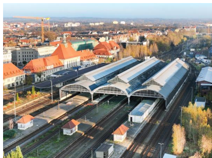
Wir modernisieren die historische Bahnsteighalle sowie die Glaswände umfangreich (November 2022) [Quelle: DB Station&Service AG/Vectorvision]
