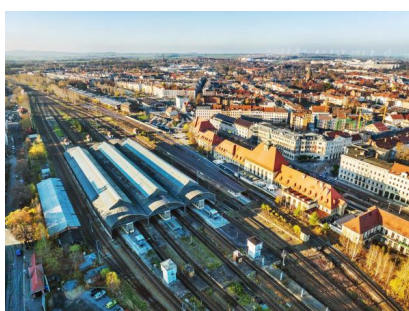
Wir modernisieren die historische Bahnsteighalle sowie die Glaswände umfangreich (November 2022) [Quelle: DB Station&Service AG/Vectorvision]
