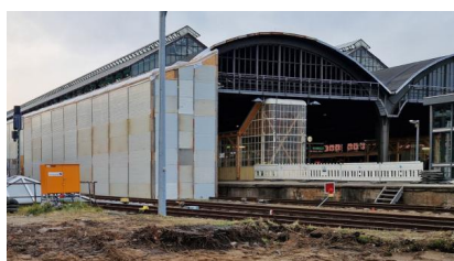
Die Südseite der Bahnsteighalle wird für die späteren Sandstrahlarbeiten eingehüllt (Dezember 2025) [Quelle: Deutsche Bahn AG/Andreas Bach]
