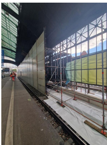
Die Südseite der Bahnsteighalle wird für die späteren Sandstrahlarbeiten eingehüllt (September 2025) [Quelle: Deutsche Bahn AG/Andreas Bach]
