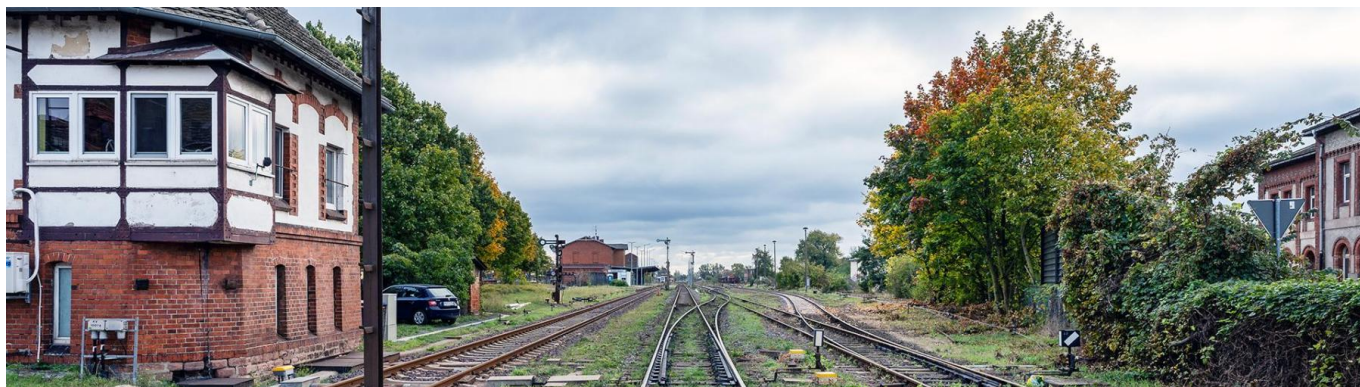
Der Bahnhof Haldensleben vor den Umbauarbeiten (Oktober 2023) [Quelle: DB Netz AG/Jörn Daberkow]
