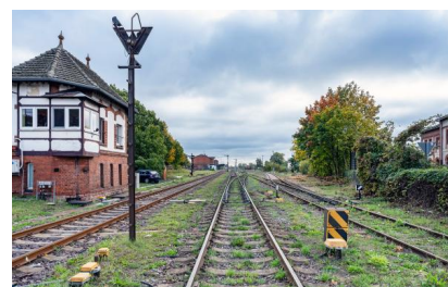
Der Bahnhof Haldensleben vor den Umbauarbeiten (Oktober 2023) [Quelle: DB Netz AG/Jörn Daberkow]
