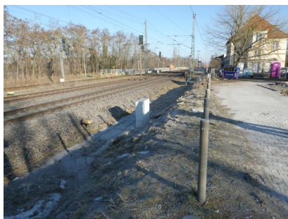
Das Stellwerk nach dem Rückbau im Januar 2026 (Januar 2026) [Quelle: DB InfraGO AG]
