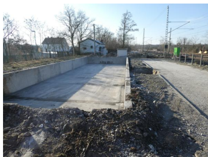
Das Stellwerk nach dem Rückbau im Januar 2026 (Januar 2026) [Quelle: DB InfraGO AG]
