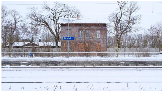
Blick auf den Bahnhof Gerwisch (Januar 2026) [Quelle: DB InfraGO AG/Jörn Daberkow]
