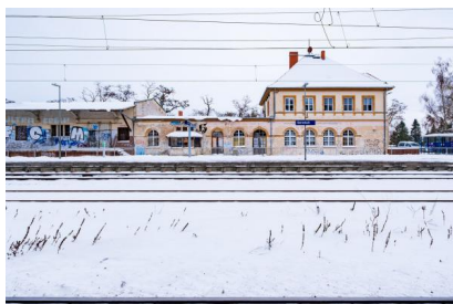
Blick auf den Bahnhof Gerwisch (Januar 2026) [Quelle: DB InfraGO AG/Jörn Daberkow]
