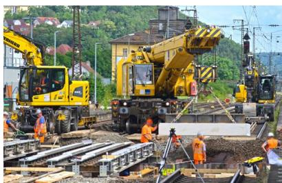
Die Hilfsbrücken werden über der Baugrube für die neue Personenunterführung eingebaut (Juni 2024) [Quelle: Deutsche Bahn AG/Christian Bedeschinski]
