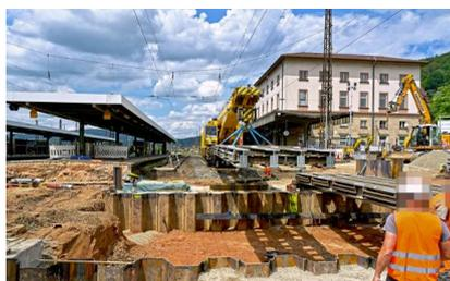
Einhub der Hilfsbrücken über der Baugrube für die neue Personenunterführung (Juni 2024) [Quelle: Deutsche Bahn AG/Christian Bedeschinski]
