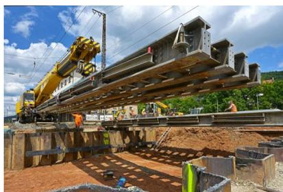
Einhub der Hilfsbrücken über der Baugrube für die neue Personenunterführung (Juni 2024) [Quelle: Deutsche Bahn AG/Christian Bedeschinski]
