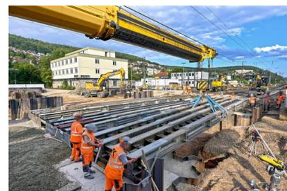
Die Hilfsbrücken werden über der Baugrube für die neue Personenunterführung eingebaut (Juni 2024) [Quelle: Deutsche Bahn AG/Christian Bedeschinski]
