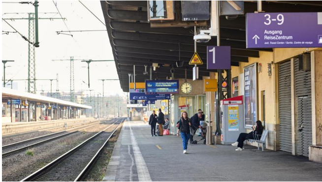
Bestandsaufnahme des Bahnsteigs 1 (März 2025) [Quelle: DB InfraGO AG/Stefan Wildhirt]
