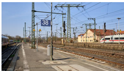
Bestandsaufnahme des Bahnsteigs 38 (März 2025) [Quelle: DB InfraGO AG/Stefan Wildhirt]
