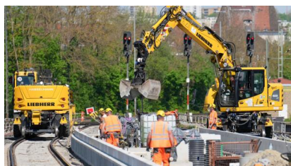
Blick auf die Arbeiten am Bahnsteig 36/37 (April 2025) [Quelle: Deutsche Bahn AG/Oliver Lang]
