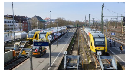
Bestandsaufnahme der Bahnsteige 36/37 und 38 (März 2025) [Quelle: DB InfraGO AG/Stefan Wildhirt]
