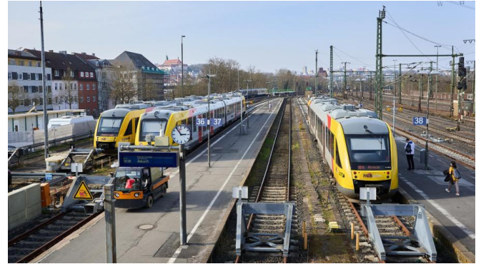
Bestandsaufnahme der Bahnsteige 36/37 und 38 (März 2025) [Quelle: DB InfraGO AG/Stefan Wildhirt]
