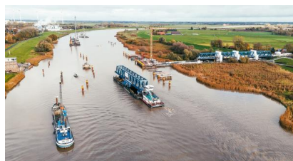
Das rund 70 Meter lange und circa 700 Tonnen schwere Brückenteil wird auf einem Ponton circa sieben Kilometer über die Ems nach Weener transportiert (Oktober 2024) [Quelle: DB InfraGO AG]
