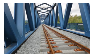
Die Schienen auf der Zweifeldbrücke (Mai 2025) [Quelle: DB InfraGO AG]
