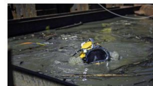
Für die vorbereitenden Arbeiten zum Herstellen der Unterwasserbetonsohle für die Vorlandpfeiler auf der Seite Westoverledingen waren auch Taucher:innen im Einsatz (August 2023) [Quelle: KIEKSTE Medienproduktion]
