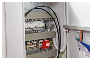
Wir haben die Verkabelungen der Schaltschränke durchgeführt (August 2024) [Quelle: DB InfraGO AG]
