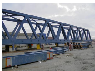
Blick auf die fertiggestellte Einfeldbrücke (Februar 2024) [Quelle: DB InfraGO AG]
