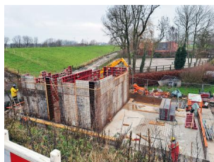
Wir haben die Bodenplatten für die neue Netzstation und das Elektronische Stellwerk auf der Seite Westoverledingen hergestellt (Dezember 2023) [Quelle: DB Netz AG]
