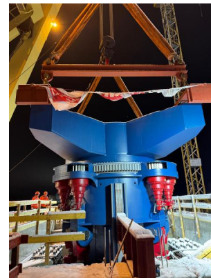
Die Hubsäule wurde bei Schneefall in den Drehpfeiler eingehoben (November 2024) [Quelle: DB InfraGO AG]
