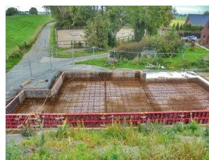
Wir stellen eine sogenannte Bewehrung für die Bodenplatte der Netzstation auf der Seite Westoverledingen her (September 2023) [Quelle: DB Netz AG]
