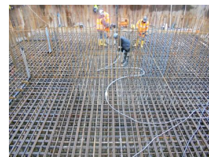
Blick auf die Anschlussbewehrung für den aufgehenden Bauwerksteil der Pfahlkopfplatte (Dezember 2023) [Quelle: DB Netz AG]
