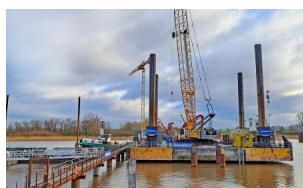
Wasserseitiges Herstellen der Mikropfähle in der Baugrube der Achse 20 (November 2023) [Quelle: DB Netz AG]
