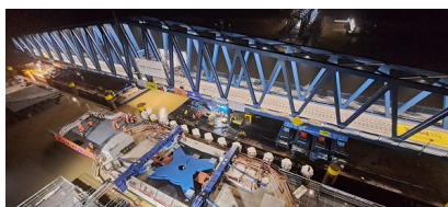
Das Brückenelement wurde auf Pontons an die Baustelle gebracht (Dezember 2024) [Quelle: DB InfraGO AG]
