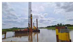
Wir haben die Installation von Leitwerksdalben am Spitzenlager vorgenommen (Juni 2024) [Quelle: DB InfraGO AG]
