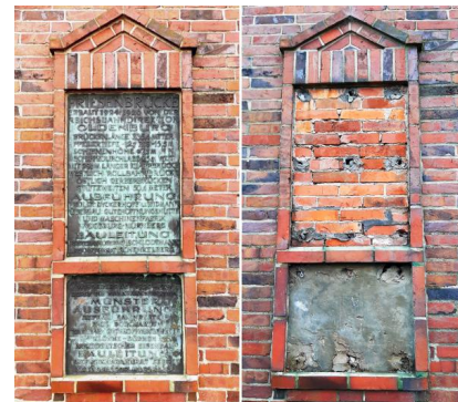
Historische Bronzetafeln am denkmalgeschützten Brückenwärterhaus dokumentierten den Bau der alten Friesenbrücke. Auch nach der Sanierung des Gebäudes im Rahmen des Friesenbrücke-Neubaus war vorgesehen, diese als Zeugnis einer vergangenen Ära zu erhalten. Doch die geschichtsträchtigen Bronzetafeln wurden kürzlich entwendet. Nun klafft nicht nur in der alten Brücke, sondern auch an der Wand des Brückenwärterhauses eine unübersehbare Lücke (Juli 2021) [Quelle: DB Netz AG]
