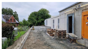
Bodenarbeiten an der Netzstation (Juli 2025) [Quelle: DB InfraGO AG]
