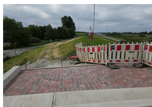
Der Fuß- und Radweg wurde auf der Ihrhover Seite gepflastert (Mai 2025) [Quelle: DB InfraGO AG]
