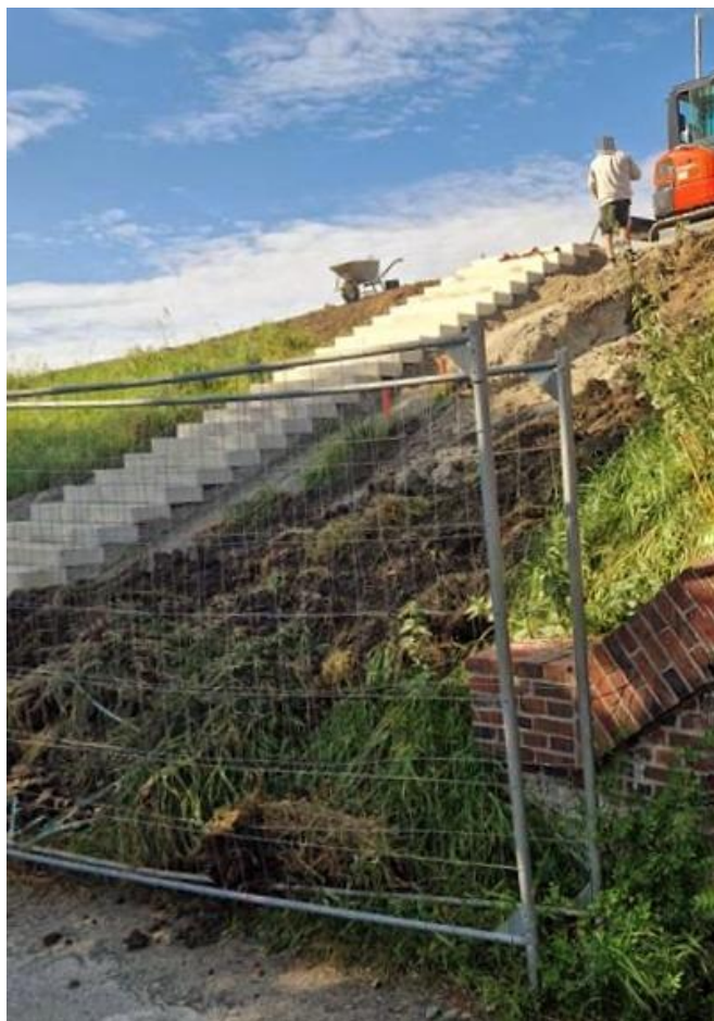
Die Zuwegungen zum Fuß- und Radweg wurden von den Kommunen fertiggestellt (August 2025) [Quelle: DB InfraGO AG]
