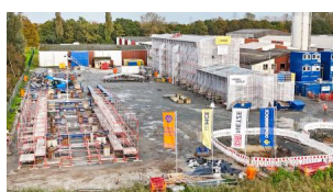
Die Beschichtung der Einfeldbrücke auf der Fläche im Hafen Papenburg hat begonnen (November 2023) [Quelle: DB Netz AG]
