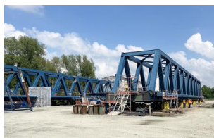
Die beiden Vorlandbrücken auf der Seite Westoverledingen sind nahezu fertiggestellt (Mai 2024) [Quelle: DB InfraGO AG]
