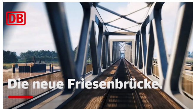
YouTube: Einblick in die Konstruktion des neuen Bauwerks (Niederlande onderiteling aanwezig) (Dezember 2023) [Quelle: KIEKSTE Medienproduktion/eberhardt – die ingenieure GmbH]
