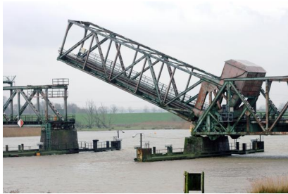
Die Friesenbrücke vor dem Unfall (November 2015) [Quelle: DB Netz AG/Alexander Heinemann]
