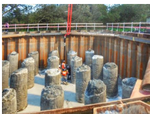
In Vorbereitung auf Betonagearbeiten wurde das Wasser in der Baugrube abgepumpt (September 2023) [Quelle: DB Netz AG]
