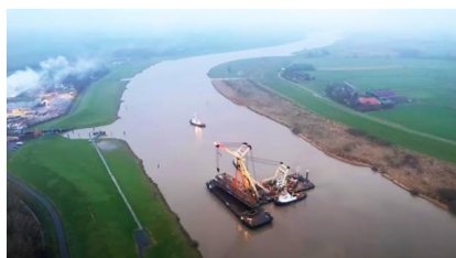
YouTube: Die Friesenbrücke wird zurückgebaut und abtransportiert (Februar 2022) [Quelle: Depenbrock Ingenieurwasserbau]
