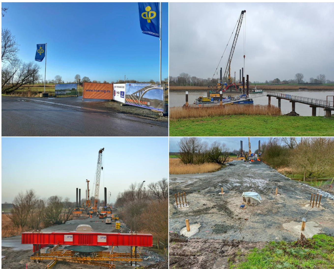
Wir haben Bohrpfähle im Deichvorland hergestellt und Probepfahlbelastungen im Deichvorland und im Bereich der Widerlager Weener und Westoverledingen durchgeführt. Zudem haben wir einen Boatsanleger gebaut (Januar 2023) [Quelle: DB Netz AG]
