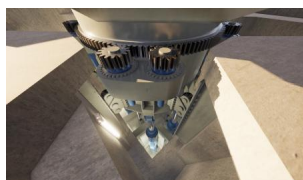
Wir haben die Rollendrehverbindungen am Hubelement montiert und das Zahnflankenspiel eingestellt (Oktober 2024) [Quelle: eberhardt – die ingenieure GmbH]
