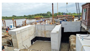
Zwischen dem Widerlager (Achse 10) und dem Brückenwärterhaus haben wir eine senkrechte Flügelfwand hergestellt (August 2024) [Quelle: DB InfraGO AG]
