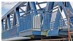
Wir haben an der Einfeldbrücke die Befestigung für die Schranken montiert (Juli 2024) [Quelle: DB InfraGO AG]
