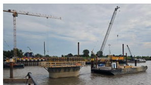
Am Flusspfeiler (Achse 20) haben wir weitere Beton- und Kolkchutzarbeiten durchgeführt (September 2024) [Quelle: DB InfraGO AG]
