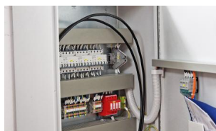
Wir haben die Verkabelungen der Schaltschränke durchgeführt (August 2024) [Quelle: DB InfraGO AG]
