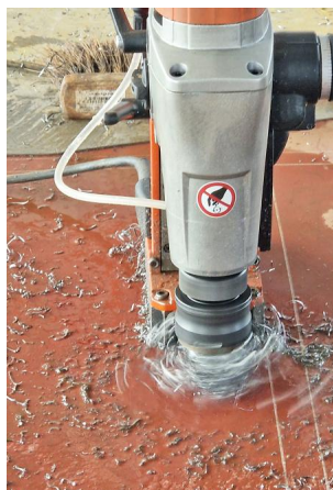
Wir haben die Drehbrücke in voller Länge montiert und die Bohrungen für die sogenannte Feste Fahrbahn vorgenommen (August 2024) [Quelle: DB InfraGO AG]
