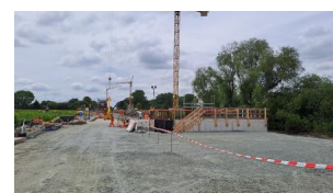
Am Vorlandpfeiler Westoverledingen haben wir Lagersockel hergestellt, die Baugruben aufgefüllt und Spundwände gesetzt (Juni 2024) [Quelle: DB InfraGO AG]
