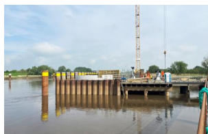
Die Betonarbeiten des Flusspfeilers der Hub-Drehbrücke schreiten voran und ragen bereits über die Baugrube hinaus (Mai 2024) [Quelle: DB InfraGO AG]
