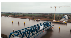
YouTube: Einschwimmen der Friesenbrücke – Die Einfeldbrücke (Oktober 2024) [Quelle: Deutsche Bahn AG]
