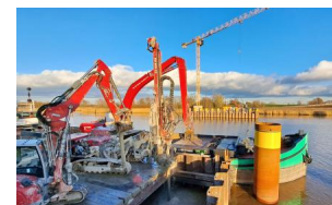
Aufstellen eines Obendrehkran an der aufgeständerten Arbeitsebene zur Materiallandienung der Baugrube im Bereich des Drehpfeilers (November 2023) [Quelle: DB Netz AG]
