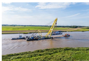
Das erste Bauteil der Zweifeldbrücke wird über die Ems nach Westoverledingen eingeschommen (Juli 2024) [Quelle: DB InfraGO AG]
