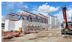
Die Montagearbeiten des Fachwerks an der Drehbrücke schreiten voran (Juli 2024) [Quelle: DB InfraGO AG]
