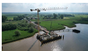
Blick auf den Fortschritt der Betonarbeiten an den Innen- und Außenwänden des Drehpfeilers im Fluss (Juni 2024) [Quelle: DB InfraGO AG]
