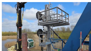
Die Schifffahrtssignale wurden an den Spitzenlagern der Brücke montiert (März 2025) [Quelle: DB InfraGO AG]
