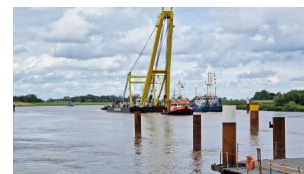
Blick auf den niederländischen Schwimmkran „Cormorant“ (Juli 2024) [Quelle: DB InfraGO AG]
