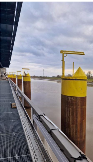
Montierte Dalbenköpfe (Februar 2025) [Quelle: DB InfraGO AG]
