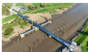
Die geschlossene Brücke – Übersicht über das Baufeld (April 2025) [Quelle: DB InfraGO AG]
