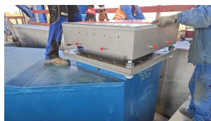
Die Lager der drehbaren Konstruktion wurden erfolgreich eingebaut (März 2025) [Quelle: DB InfraGO AG]
