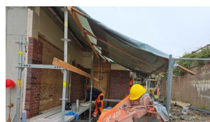
Blick auf die Klinkerarbeiten an der Netzstation (Juni 2024) [Quelle: DB InfraGO AG]
