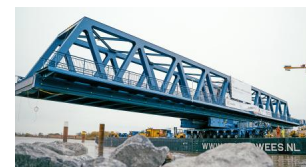
Wir positionieren das Brückenteil (Oktober 2024) [Quelle: DB InfraGO AG]
