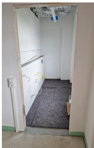
Wir installieren die Sanitäranlagen im Brückenwärterhaus (Juli 2024) [Quelle: DB InfraGO AG]
