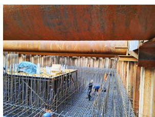
Wir haben im Bereich des Drehpfeilers Bewehrungsarbeiten durchgeführt, um die Betonagearbeiten vorzubereiten (Januar 2024) [Quelle: DB InfraGO AG]
