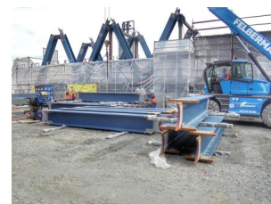
Die Diagonalstreben der Einfeldbrücke werden im Hafen Papenburg montiert (September 2023) [Quelle: DB Netz AG]
