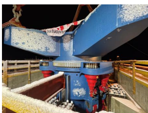
Die Hubsäule wurde bei Schneefall in den Drehpfeiler eingehoben (November 2024) [Quelle: DB InfraGO AG]
