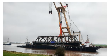
Friesenbrücke ahoi: Das alte Brückenteil wird vor Ort in Weener auf einen Ponton verladen und anschließend nach Papenburg transportiert (Dezember 2021) [Quelle: DB Netz AG/Alexander Heinemann]
