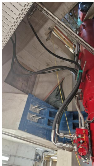
Anschlussarbeiten an den Hubzylindern (Februar 2025) [Quelle: DB InfraGO AG]
