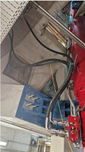
Anschlussarbeiten an den Hubzylindern (Februar 2025) [Quelle: DB InfraGO AG]
