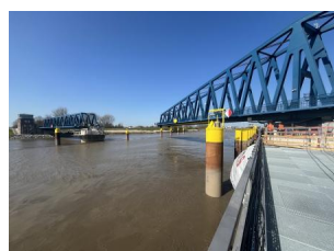
Das Drehelement der Friesenbrücke ist erstmalig erprobt worden (April 2025) [Quelle: DB InfraGO AG]
