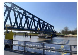
Das Drehelement der Friesenbrücke ist erstmalig erprobt worden (April 2025) [Quelle: DB InfraGO AG]
