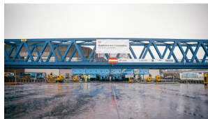
Blick auf die Einfeldbrücke im Papenburger Hafen (Oktober 2024) [Quelle: DB InfraGO AG]
