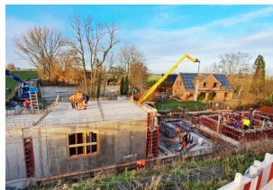
Die Wände der Netzstation wurden errichtet (Januar 2024) [Quelle: DB InfraGO AG]
