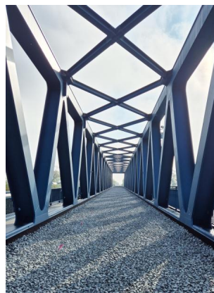
Der Gleisschotter auf der Zweifeldbrücke (April 2025) [Quelle: DB InfraGO AG]
