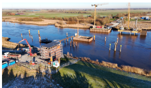
Blick auf das Brückenwärterhaus. Hier stocken wir das Fassadengerüst für den anstehenden Bau des Dachs auf und montieren den aufgehenden Holzbau (Januar 2024) [Quelle: DB InfraGO AG]
