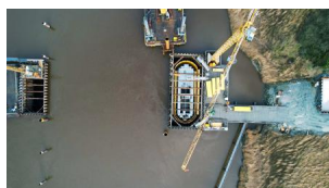
Die Arbeiten für den Drehpfeiler im Fluss aus der Vogelperspektive (Februar 2024) [Quelle: DB InfraGO AG]
