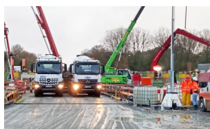
Mithilfe von 150 Betonmischer-Fahrten in 14 Stunden wurden circa 1.275 Kubikmeter Unterwasserbeton eingebracht (November 2023) [Quelle: DB Netz AG]
