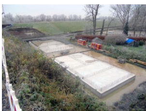
Blick auf die Bodenplatten für die neue Netzstation und das Elektronische Stellwerk auf der Seite Westoverledingen (November 2023) [Quelle: DB Netz AG]
