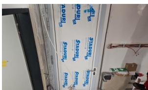
Alle Türen wurden im Brückenwärterhaus verbaut (Juni 2025) [Quelle: DB InfraGO AG]
