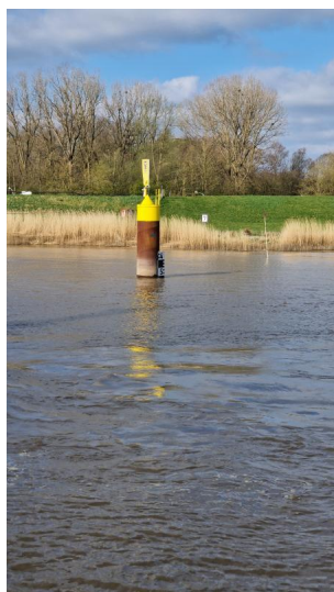
Wasserstandsanzeigen (Pegelanzeigen) wurden an den Dalben angebracht (April 2025) [Quelle: DB InfraGO AG]
