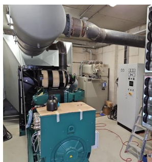
Die Netzersatzanlage wird in die Netzstation eingebaut (November 2024) [Quelle: DB InfraGO AG]
