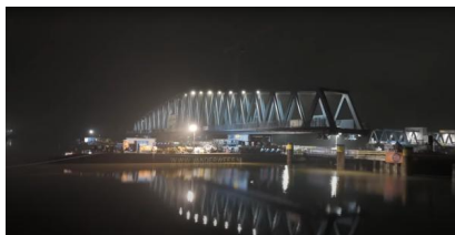
YouTube: Einschwimmen der Friesenbrücke – Die Drehbrücke (Dezember 2024) [Quelle: Deutsche Bahn AG]
