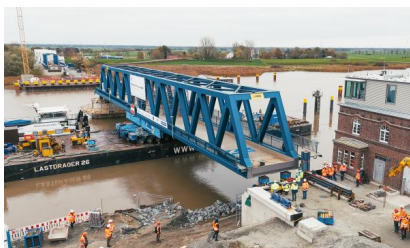
Wir positionieren das Brückenteil (Oktober 2024) [Quelle: DB InfraGO AG]
