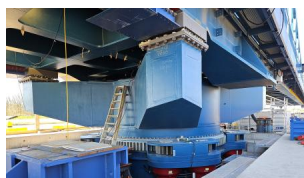
Das Drehteil auf der Hubsäule (April 2025) [Quelle: DB InfraGO AG]
