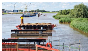
Um die Tragfähigkeit der Spitzenlager zu erhöhen, haben wir diese mit Sand aufgefüllt (Juli 2024) [Quelle: DB InfraGO AG]
