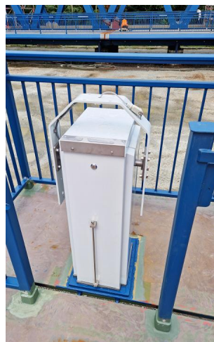
Blick auf die Befestigung für die Schranken (Juli 2024) [Quelle: DB InfraGO AG]
