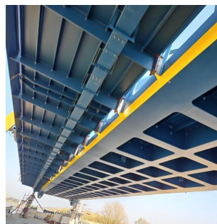
Gelbe Farbelemente unter der Brücke sorgen für bessere Sichtbarkeit (März 2025) [Quelle: DB InfraGO AG]
