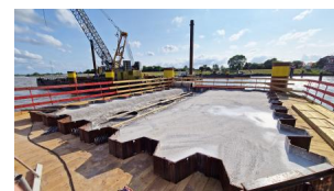
Am Spitzenlager Süd haben wir unter anderem zum Schutz vor Feuchtigkeit zusätzlich eine Sauberkeitsschicht betoniert (Juli 2024) [Quelle: DB InfraGO AG]
