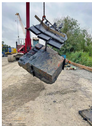
Im Rahmen der Nassbaggerungen werden auch Hindernisse geborgen, um die Arbeiten nicht zu beeinträchtigen (August 2023) [Quelle: DB Netz AG]
