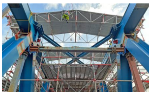
Die Gerüstbauarbeiten am Überbau für die Einhausung für die nachfolgenden Korrosionsschutzarbeiten sind abgeschlossen (Oktober 2023) [Quelle: DB Netz AG]
