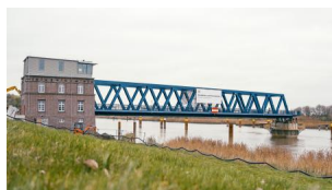
Blick auf die Einfeldbrücke in Weener (Oktober 2024) [Quelle: DB InfraGO AG]
