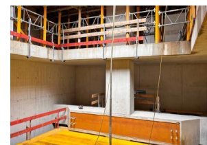
Am Drehpfeiler im Fluss haben wir die Betonarbeiten der Zwischendecken abgeschlossen (August 2024) [Quelle: DB InfraGO AG]
