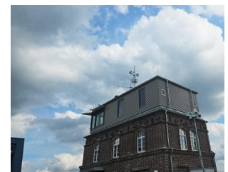
Der AIS-Mast (Automatisches Identifikationssystem) auf dem Brückenwärterhaus (April 2025) [Quelle: DB InfraGO AG]
