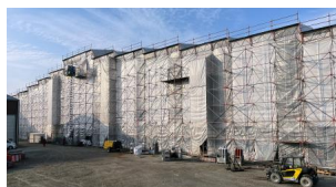
Wir haben die Montagearbeiten an der Drehbrücke fertiggestellt und die Einhausung demontiert. Es folgen weitere Montagearbeiten für den Geh-, Rad- und Dienstgehweg (September 2024) [Quelle: DB InfraGO AG]
