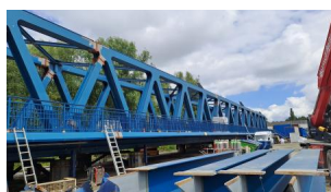
Wir haben die Lagerflächen der Ein- und Zweifeldbrücken gefräst (Juni 2024) [Quelle: DB InfraGO AG]
