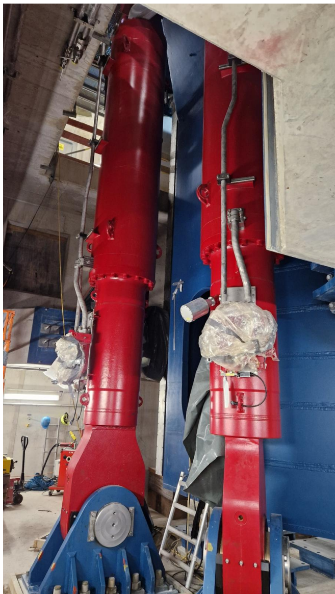
Verrohrung der Hub-Drehsäule (Januar 2025) [Quelle: DB InfraGO AG]
