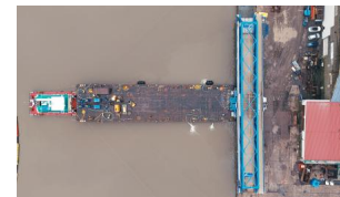
Das Brückenteil wird auf das Schwimmponton übersetzt (Oktober 2024) [Quelle: DB InfraGO AG]
