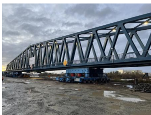
Die Brücke wurde an den Hublagerpunkten angehoben (November 2024) [Quelle: DB InfraGO AG]
