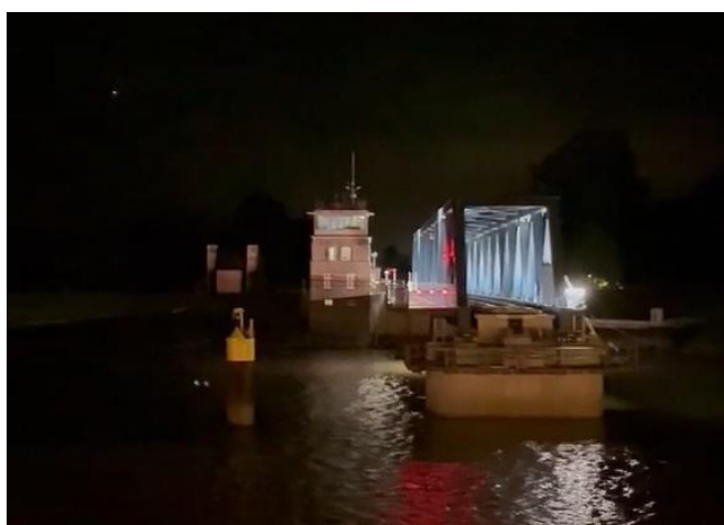
YouTube: Impressionen der Beleuchtung (August 2025) [Quelle: DB InfraGO AG]
