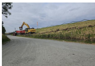
Die Kommunen haben mit den ersten Arbeiten an den Anrampungen für den Geh- und Radweg begonnen (Juni 2025) [Quelle: DB InfraGO AG]
