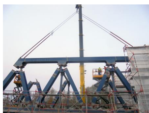
Zeitgleich zu den Schlosser- und Schweißarbeiten treffen sukzessive die Teile für die Zweifeldbrücke ein (November 2023) [Quelle: DB Netz AG]
