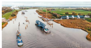
Das rund 70 Meter lange und circa 700 Tonnen schwere Brückenteil wird auf einem Ponton circa sieben Kilometer über die Ems nach Weener transportiert (Oktober 2024) [Quelle: DB InfraGO AG]
