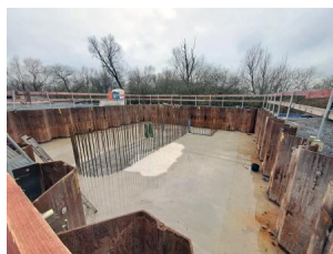
Blick auf die Anschlussbewehrung für den aufgehenden Bauwerksteil der Pfahlkopfplatte (Dezember 2023) [Quelle: DB Netz AG]
