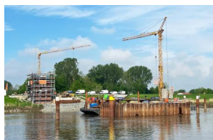
Wir haben die Betonarbeiten am Flusspfeiler in Weener fortgeführt (Mai 2024) [Quelle: DB InfraGO AG]
