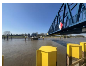
Das Drehelement der Friesenbrücke ist erstmalig erprobt worden (April 2025) [Quelle: DB InfraGO AG]
