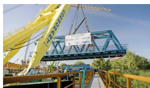
Das erste Bauteil der Zweifeldbrücke wurde über die Ems nach Westoverledingen eingeschommen (Juli 2024) [Quelle: DB InfraGO AG]
