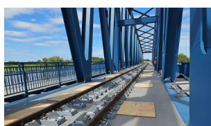
Die Langschienen auf der Drehbrücke (Mai 2025) [Quelle: DB InfraGO AG]
