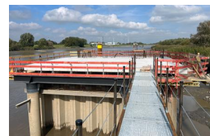
Wir haben weitere Betonarbeiten am Spitzenlager durchgeführt (September 2024) [Quelle: DB InfraGO AG]
