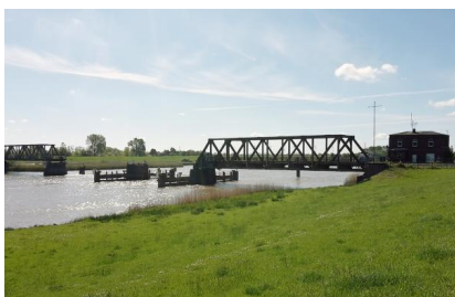
Die Friesenbrücke heute (Mai 2019) [Quelle: DB Netz AG/Alexander Heinemann]
