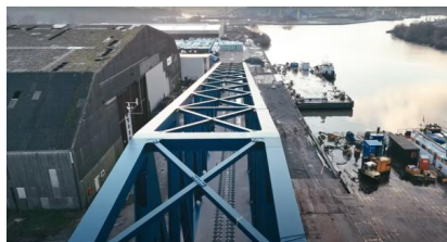
YouTube: Einschwimmen und Montage der Friesenbrücke – die Drehbrücke (September 2025) [Quelle: DB InfraGO AG]
