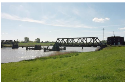
Die Friesenbrücke heute (Mai 2019) [Quelle: DB Netz AG/Alexander Heinemann]
