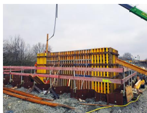
Wir führen Schalungs- und Bewehrungsarbeiten an dem Vorlandpfeiler (Achse 50) durch (Februar 2024) [Quelle: DB InfraGO AG]
