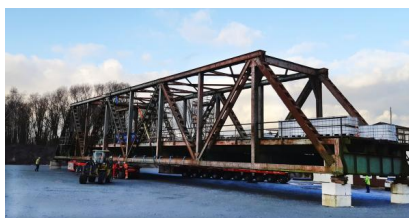
Der Überbau der alten Friesenbrücke ist im Hafen Papenburg angelangt. Hier wird das stählerne Bauteil zerlegt und verwertet (Dezember 2021) [Quelle: DB Netz AG/Stefan Schwede]
