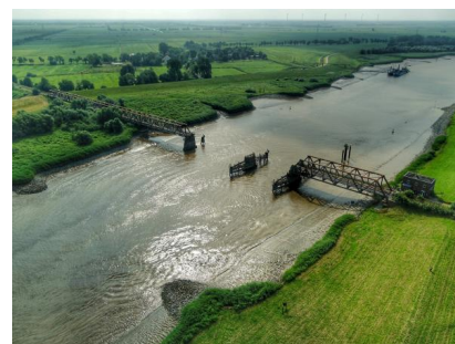
Die Friesenbrücke aus der Vogelperspektive: Per Multikopter werden Aufnahmen vom Bauwerk und seiner unmittelbaren Umgebung gemacht. Dies dient zur Beweissicherung und hilft dabei, den Zustand der umliegenden Flächen nach dem Neubau der Brücke wiederherzustellen (August 2021) [Quelle: DB Sicherheit GmbH]
