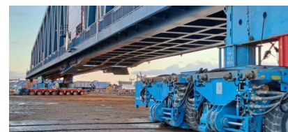
Das Drehelement wurde auf mehrachsige, selbstfahrende Transporteinheiten für Schwertransporte verladen (Dezember 2024) [Quelle: DB InfraGO AG]
