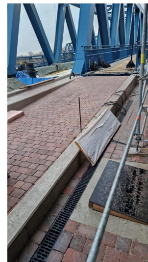
Pflasterarbeiten vor dem Brückenwärterhaus im Übergangsbereich des Geh- und Radweges (Februar 2025) [Quelle: DB InfraGO AG]
