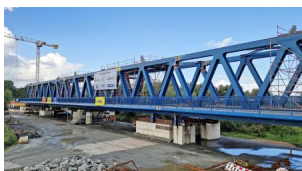
Die vier Brückenteile der Zweifeldbrücke wurden auf provisorischen Lagern im Vorland Westoverledingen abgelegt. Auf diesen wird sie verschweißt und in Endposition gebracht (August 2024) [Quelle: DB InfraGO AG]
