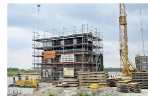
Auf der Weeneraner Seite schreiten die Sanierung und der Ausbau des Brückenwärterhauses voran (Mai 2024) [Quelle: DB InfraGO AG]
