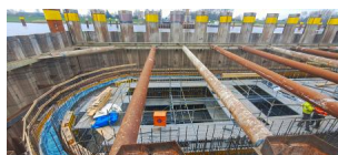
Blick auf die betonierte Sohlplatte für den Drehpfeiler im Fluss (Februar 2024) [Quelle: DB InfraGO AG]
