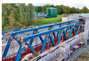
Die Beschichtung der Einfeldbrücke auf der Fläche im Hafen Papenburg hat begonnen (November 2023) [Quelle: DB Netz AG]
