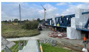
Die vier Brückenteile der Zweifeldbrücke wurden im Deichvorland ausgerichtet. Die Schweißarbeiten zur Verbindung der Teile haben begonnen (September 2024) [Quelle: DB InfraGO AG]
