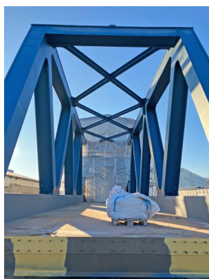
Blick auf die beschichtete Einfeldbrücke (Januar 2024) [Quelle: DB InfraGO AG]
