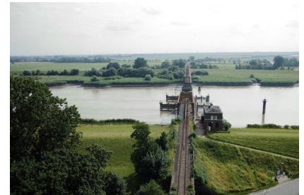
Die alte Friesenbrücke aus der Vogelperspektive [Quelle: Ingenieurbüro Drecoll]
