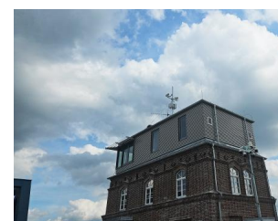
Der AIS-Mast (Automatisches Identifikationssystem) auf dem Brückenwärterhaus (April 2025) [Quelle: DB InfraGO AG]
