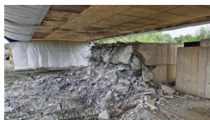
Rückbau der provisorischen Brückenlager (Juli 2025) [Quelle: DB InfraGO AG]
