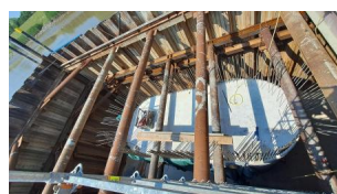
Blick auf die Innenseite des Flusspfeilers (Achse 20) auf der Seite Weener (Juni 2024) [Quelle: DB InfraGO AG]
