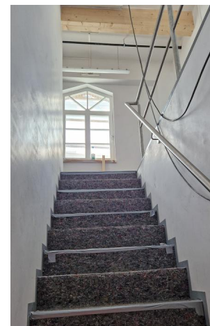
Im Brückenwärterhaus haben wir das Geländer an der Treppe zum Erdgeschoss montiert (August 2024) [Quelle: DB InfraGO AG]
