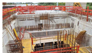
Am Flusspfeiler (Achse 20) haben weitere Betonarbeiten stattgefunden. Der Spundwandkasten wurde zurückgebaut (August 2024) [Quelle: DB InfraGO AG]
