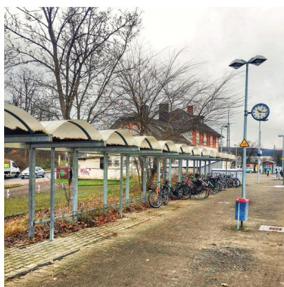
Die Bike&Ride-Anlage wurde bereits zurückgebaut. Wir errichten noch eine provisorische Fahrradabstellanlage (Januar 2022) [Quelle: DB Station&Service AG]
