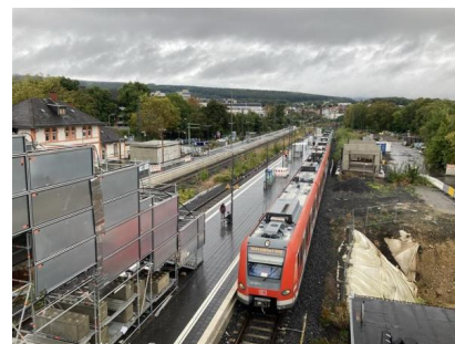
Blick von der provisorischen Personenüberführung auf den Mittelbahnsteig – ebenfalls im Bild die Fertigteile für die Betonröhre (September 2024) [Quelle: DB InfraGO AG]
