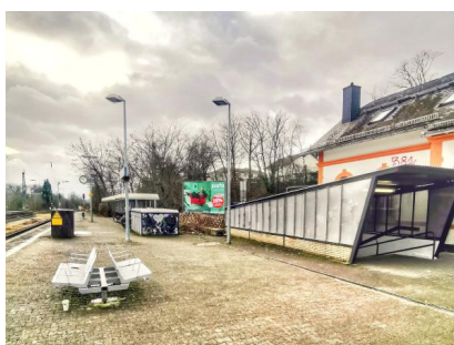
Während der Arbeiten werden wir eine provisorische Personenüberführung errichten (Januar 2022) [Quelle: DB Station&Service AG]
