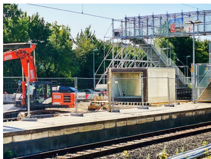
Die provisorische Personenüberführung dient als Verbindung zwischen dem Bahnsteig und der Stadt (September 2023) [Quelle: DB Station&Service AG]
