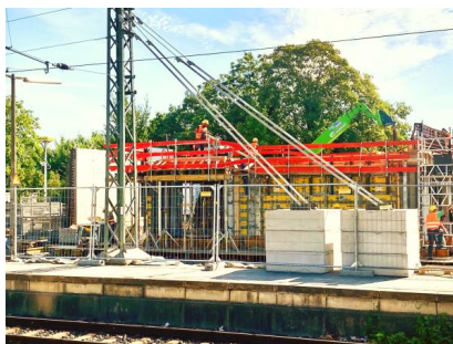
Blick auf die Bauarbeiten (September 2023) [Quelle: DB Station&Service AG]
