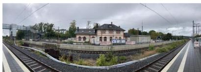
Blick auf den Hausbahnsteig mit Verbau zur Sicherung der Gleise zwischen den Gleisen 402 und 404 (September 2024) [Quelle: DB InfraGO AG]
