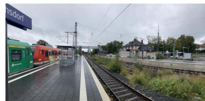
Mittelbahnsteig (Gleise 404/405) mit neuem Bahnsteigbelag und Ausstattungselementen (September 2024) [Quelle: DB InfraGO AG]
