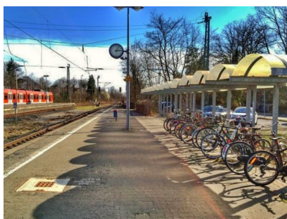
Um die Station barrierefrei auszubauen, sind verschiedene Arbeiten notwendig (März 2022) [Quelle: DB Station&Service AG]
