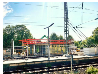
Blick auf die Bauarbeiten (September 2023) [Quelle: DB Station&Service AG]
