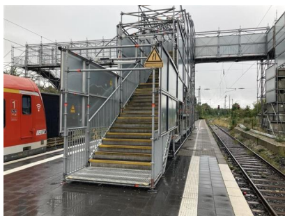
Aufgang zur provisorischen Personenüberführung – diese dient als Stadtteilverbindung (September 2024) [Quelle: DB InfraGO AG]
