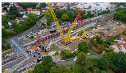
Blick auf den Einhub der neuen Personenunterführung (Juli 2025) [Quelle: DB InfraGO AG]
