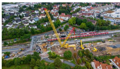
Die eingehobene Personenunterführung in ihrer Endlage (Juli 2025) [Quelle: DB InfraGO AG]
