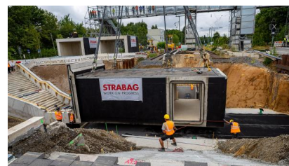
Die neue Personenunterführung wird in ihre Endlage eingehoben (Juli 2025) [Quelle: DB InfraGO AG]
