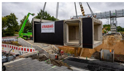
Einhub der neuen Personenunterführung (Juli 2025) [Quelle: DB InfraGO AG]
