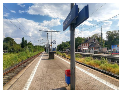
Wir werden den Bahnsteig 1 auf 96 Zentimeter erhöhen, damit die Reisenden komfortabler in die Züge ein- und aussteigen können (Juli 2018) [Quelle: DB Station&Service AG]
