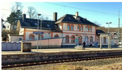
Der Bahnhof entspricht nicht mehr den heutigen Anforderungen und wird modernisiert (März 2022) [Quelle: DB Station&Service AG]
