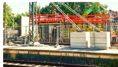
Blick auf die Bauarbeiten (September 2023) [Quelle: DB Station&Service AG]
