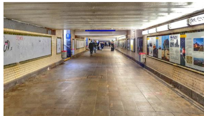
Die Personenunterführung des Bahnhofs Friedberg (Hess) vor der Modernisierung (Oktober 2020) [Quelle: DB Station&Service AG]
