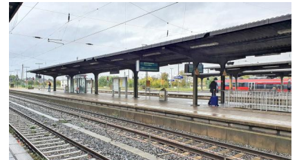
Blick auf den Mittelbahnsteig des Bahnhofs Friedberg (Hess) (Oktober 2020) [Quelle: DB Station&Service AG]
