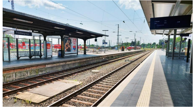
Stand der Bauarbeiten am Hausbahnsteig und am Bahnsteig Gleis 2 (Fahrtrichtung Frankfurt/Friedrichsdorf) (Juli 2021) [Quelle: DB Station&Service AG]
