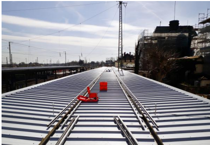
Blick auf das Dach am Hausbahnsteig während der Bauarbeiten im März 2021 [Quelle: DB Station&Service AG]
