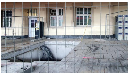
Sicherung einer Baugrube am Bahnhof Friedberg (Hess) (Oktober 2020) [Quelle: DB Station&Service AG]
