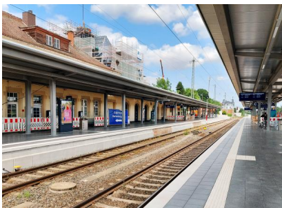
Stand der Bauarbeiten am Hausbahnsteig und am Bahnsteig Gleis 2 (Fahrtrichtung Gießen) (Juli 2021) [Quelle: DB Station&Service AG]
