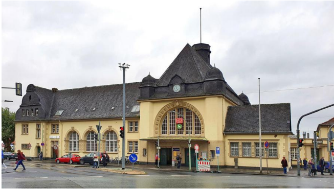
Der Bahnhof Friedberg (Hess) (Oktober 2020) [Quelle: DB Station&Service AG]
