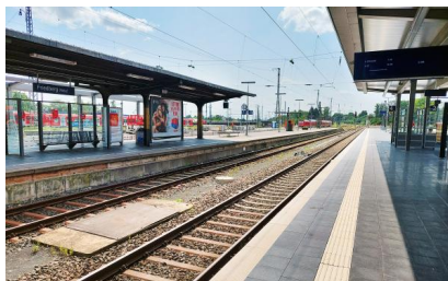
Stand der Bauarbeiten am Hausbahnsteig und am Bahnsteig Gleis 2 (Fahrtrichtung Frankfurt/Friedrichsdorf) (Juli 2021) [Quelle: DB Station&Service AG]
