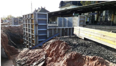
Schalung der Dachfundamente am Bahnsteig 2 mit Blick in Richtung Bahnhofsgebäude (November 2020) [Quelle: DB Station&Service AG]
