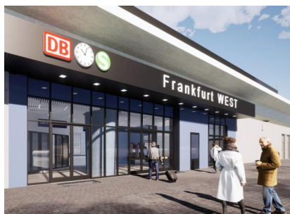
Visualisierung: Der neue Hauptzugang der Empfangshalle an der Kasseler Straße (Oktober 2023) [Quelle: Mailänder Consult GmbH]
