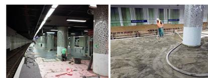
Aufbringen des Estrichbetons (rechts) im Juli 2016 und der neuen Fußbodenplatten (links) im August 2016 [Quelle: DB Station&Service AG, Regionalbereich Mitte]
