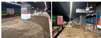
Nachdem Bodenbeläge und Unterbau entfernt wurden, konnte am S-Bahnhof Taunusanlage der Estrichbeton aufgebracht werden (Juli 2016) [Quelle: DB Station&Service AG, Regionalbereich Mitte]
