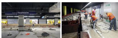
Nachdem Bodenbeläge und Unterbau entfernt wurden, konnte am S-Bahnhof Hauptwache der Estrichbeton aufgebracht werden (Juli/August 2016) [Quelle: DB Station&Service AG, Regionalbereich Mitte]
