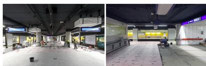
Aufbringen der neuen Fußbodenbeläge am S-Bahnhof Hauptwache (August 2016) [Quelle: DB Station&Service AG, Regionalbereich Mitte]
