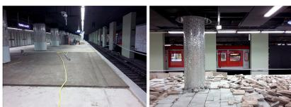
Nachdem die alten Bodenfliesen und der Unterbau am Bahnsteig 101/102 entfernt wurden, konnte mit dem neuen Bodenaufbau begonnen werden (Juli 2016) [Quelle: DB Station&Service AG, Regionalbereich Mitte]
