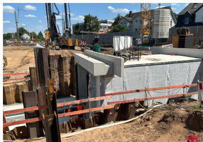
Das Rahmenbauwerk für die Personenunterführung wird eingezogen (Juli 2025) [Quelle: Stadt Frankfurt am Main/Johannes Schramm]
