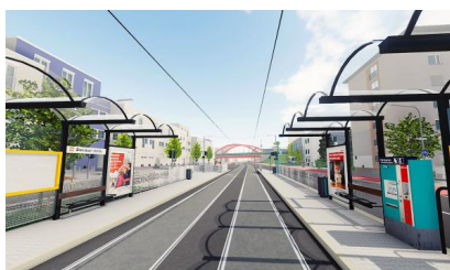
Visualisierung: Die Straßenbahnhaltestelle nach Abschluss der Bauarbeiten [Quelle: DB Netz AG, Stand: Juli 2023]
