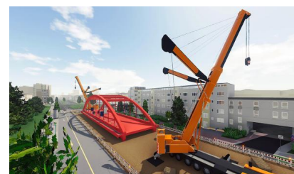
Visualisierung: Die Eisenbahnüberführung während der Vorfertigung [Quelle: DB Netz AG, Stand: Juli 2023]
