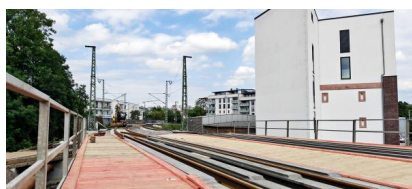
Bis Ende 2027 fahren die Züge über die im Mai 2026 eingehobenen Hilfsbrücken (Mai 2026) [Quelle: DB InfraGO AG]
