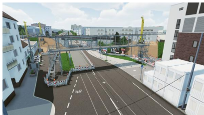
Visualisierung: Während des Einbaus der Hilfsbrücken werden Kabel über eine Kabelbrücke geführt (Dezember 2025) [Quelle: DB InfraGO AG]
