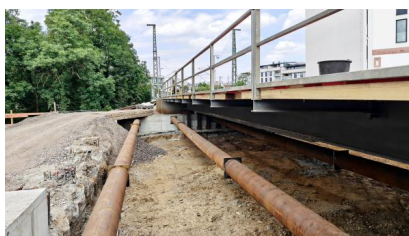
Nach dem Einbau der Hilfsbrücken können die neuen Widerlager während des laufenden Zugbetriebs betoniert werden (Mai 2026) [Quelle: DB InfraGO AG]
