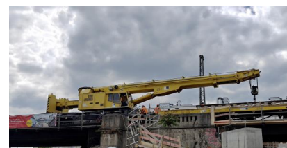
Einbau neuer Weichen mit einem Schienenkran (Mai 2026) [Quelle: DB InfraGO AG]
