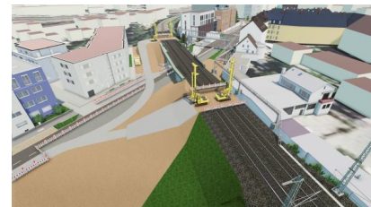
Visualisierung: Vier Bohrpfeilergeräte werden eingesetzt, um den Einbau der neuen Widerlager vorzubereiten (Dezember 2025) [Quelle: DB InfraGO AG]
