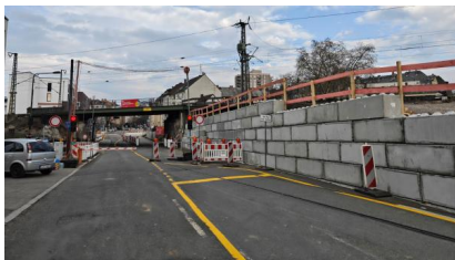
Der Standplatz des Schwerlastkrans wird durch eine Stützwand abgesichert (März 2026) [Quelle: DB InfraGO AG]
