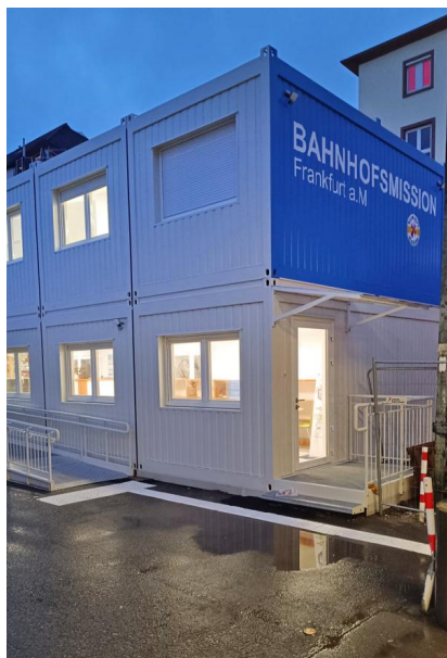
Die Bahnhofsmision befindet sich voraussichtlich bis Sommer 2025 in einer Containeranlage auf dem Parkplatz Nord (Januar 2025) [Quelle: DB InfraGO AG]
