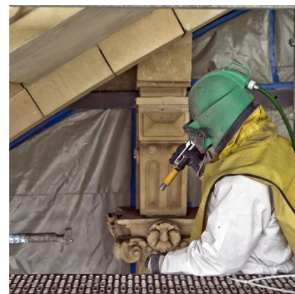
Im Partikel-Strahlverfahren wurde die Fassade schonend gereinigt [Quelle: BHP, Heidelberg]
