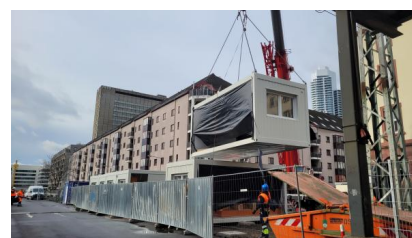
Die Containeranlage besteht insgesamt aus 18 Einzelcontainern und wird über Rampen und Treppen zugänglich sein (November 2024) [Quelle: CHS Container Handel GmbH/Iman Hashemi]
