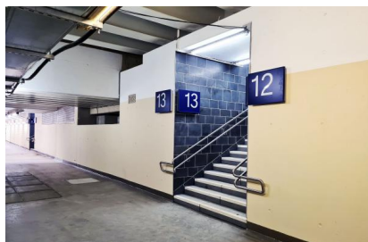
Am 3. November 2022 um 18.50 Uhr wurde die Personenunterführung im Bereich der Gleise 12 und 13 wieder eröffnet (November 2022) [Quelle: DB Station&Service AG]
