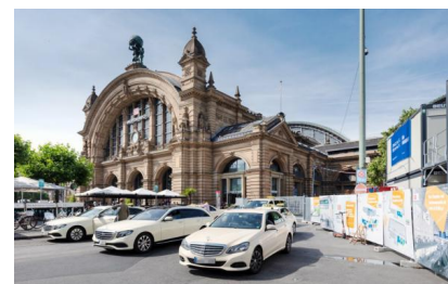
Für die Entkernung des nördlichen Teils der B-Ebene wurden die Baustelleneinrichtungsflächen erweitert (Juli 2021) [Quelle: DB Station&Service AG]
