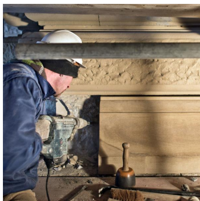
Schadhafte Teile wurden ausgebaut [Quelle: BHP, Heidelberg]
