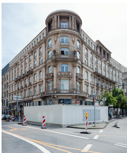
Für die Entkernung des nördlichen Teils der B-Ebene wurden die Baustelleneinrichtungsflächen erweitert (Juli 2021) [Quelle: DB Station&Service AG]
