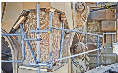
Abgestützte Rahmung der Nischenfiguren, nachdem schadhafte Teile entfernt wurden [Quelle: BHP, Heidelberg]
