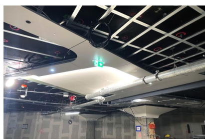
In einem Teilbereich der entkernten B-Ebene wurde eine Musterdecke angebracht (Februar 2023) [Quelle: DB Station&Service AG]
