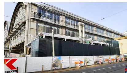
Die neue Netzversorgungsanlage wird errichtet. Diese versorgt den Hauptbahnhof im Falle eines Stromausfalls mit Energie (Februar 2022) [Quelle: DB Station&Service AG]
