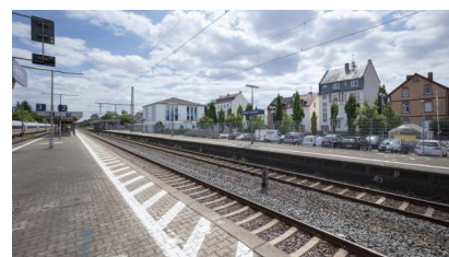
Blick auf die Gleise 2/3 (Juni 2024) [Quelle: DB InfraGO AG]
