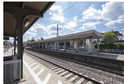
Blick auf den Hausbahnsteig 1 (Juni 2024) [Quelle: DB InfraGO AG]
