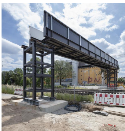
Blick auf die entstehende Behelfsbrücke (Juni 2024) [Quelle: DB InfraGO AG]
