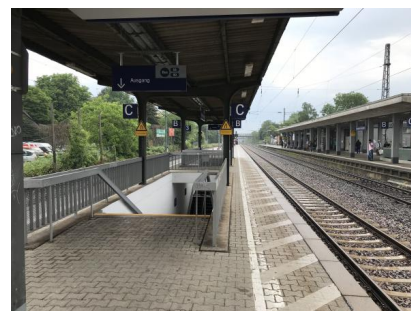
Wir modernisieren den Bahnhof und bauen ihn barrierefrei aus (April 2024) [Quelle: DB InfraGO AG]
