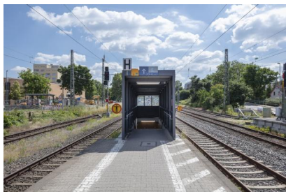
Der Eingang der Personenunterführung „Ost“ vom Bahnsteig 2 (Juni 2024) [Quelle: DB InfraGO AG]
