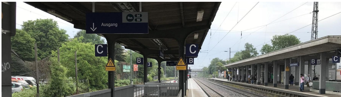
Wir modernisieren den Bahnhof und bauen ihn barrierefrei aus (April 2024) [Quelle: DB InfraGO AG]
