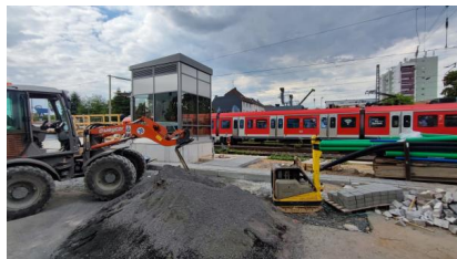
Bauarbeiten am Aufzug der neuen Personenunterführung Ost (Juli 2025) [Quelle: DB InfraGO AG]
