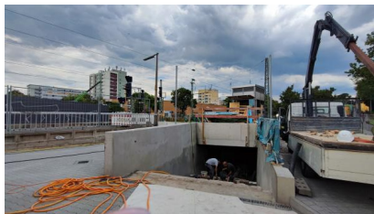
Bauarbeiten am Eingang der neuen Personenunterführung Ost (Juli 2025) [Quelle: DB InfraGO AG]
