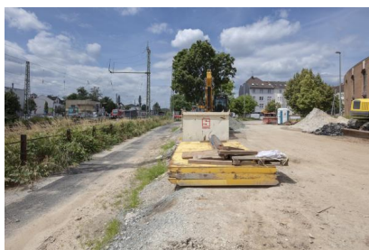
Die Baustellenfläche im Bahnhofsbereich (Juni 2024) [Quelle: DB InfraGO AG]
