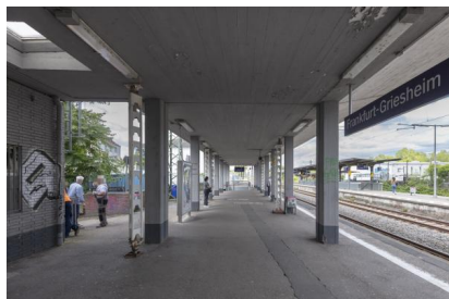
Der Bahnsteig 1 des Bahnhofs (Juni 2024) [Quelle: DB InfraGO AG]
