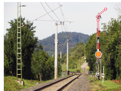
Die Eisenbahninfrastruktur zwischen Waiblingen – Schwäbisch Hall-Hessental wird auf Elektronische Stellwerkstechnik (ESTW-Technik) umgerüstet (Juli 2018) [Quelle: DB Netz AG]
