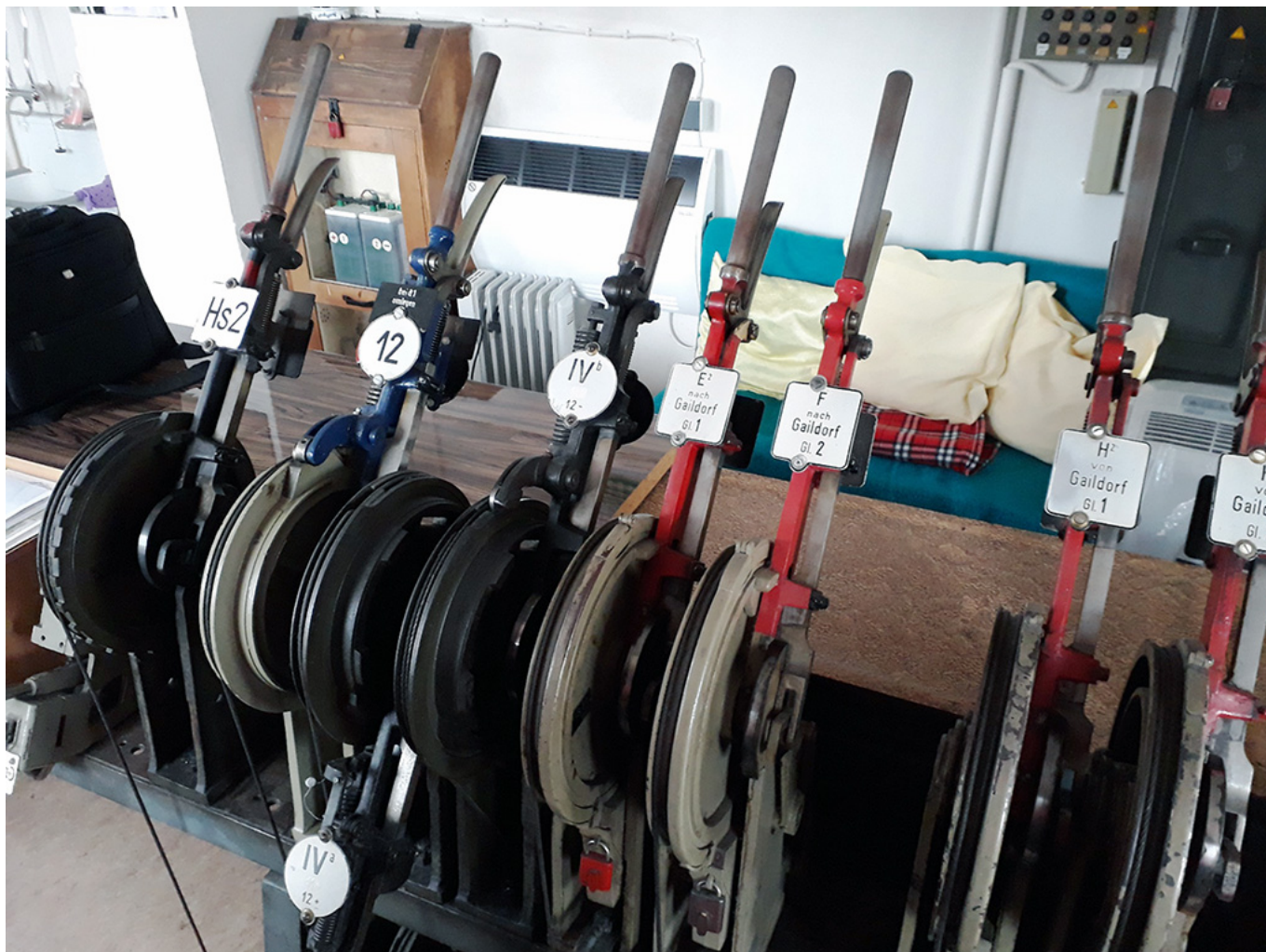
Die beiden mechanischen Stellwerke im Bahnhof Fichtenberg werden auf Elektronische Stellwerkstechnik umgerüstet (November 2017) [Quelle: DB Netz AG]
