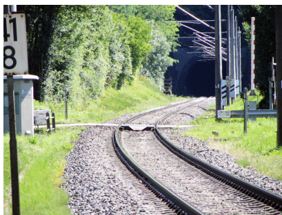
Der Bahnübergang (BÜ) „Plapphof“ wird im Rahmen des Projekts „Fichtenberg ESTW“ umgebaut (Juli 2018) [Quelle: DB Netz AG]
