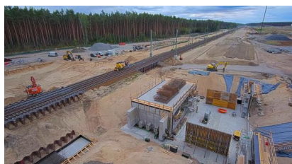
YouTube: Fangschleuse Bahnhof – Tunneleinschub im Juli 2025 (Januar 2026) [Quelle: DB InfraGO AG]
