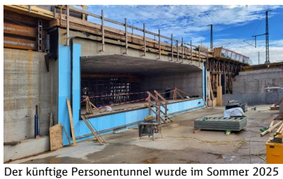
Der künftige Personentunnel wurde im Sommer 2025 unter den bestehenden Gleisen eingeschoben (Juli 2025) [Quelle: DB InfraGO AG]
