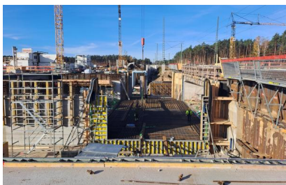
Bauarbeiten während des Tunnelleinschubs im Sommer 2025 (Juli 2025) [Quelle: DB InfraGO AG]
