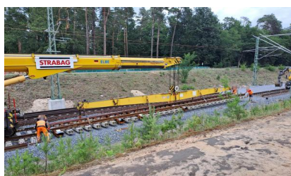
Ein neues Weichenteil wird vorsichtig auf dem Schotter abgelegt. Der Kran verteilt das Gewicht der Last gleichmäßig und hebt so besonders sicher (Juli 2025) [Quelle: DB InfraGO AG]
