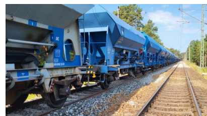
Frischer Verfüllschotter wird auf die Gleise aufgebracht. Dafür nutzen wir spezielle Entladewagen (Juli 2025) [Quelle: DB InfraGO AG]
