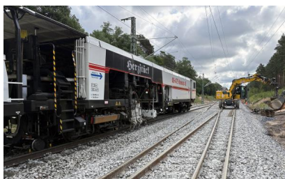
Der neue Schotter wird mit einer Stopfmaschine verdichtet. So bleibt das Gleis auch bei hohen Belastungen an seinem Platz (Juli 2025) [Quelle: DB InfraGO AG]
