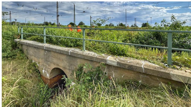
Blick auf einen zu erneuernden Durchlass (Juli 2024) [Quelle: DB InfraGO AG]
