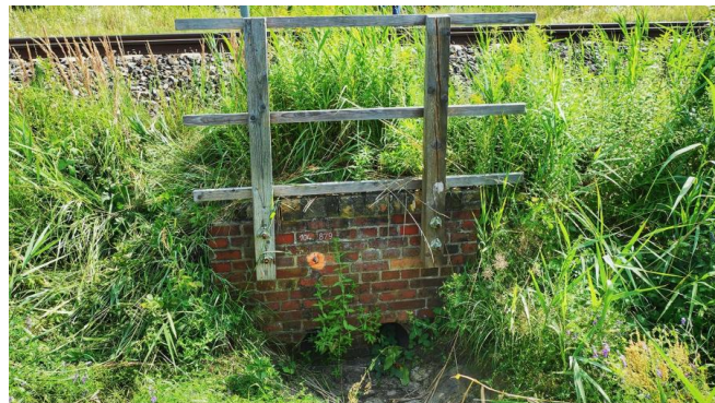
Blick auf einen zu erneuernden Durchlass (Juli 2024) [Quelle: DB InfraGO AG]
