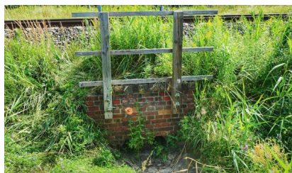
Blick auf einen zu erneuernden Durchlass (Juli 2024) [Quelle: DB InfraGO AG]
