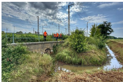
Blick auf einen zu erneuernden Durchlass (Juli 2024) [Quelle: DB InfraGO AG]
