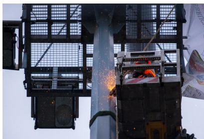
Rückbau eines Lichtmastes zur Baufeldfreimachung (Mai 2026) [Quelle: DB InfraGO AG/Jörn Daberkow]
