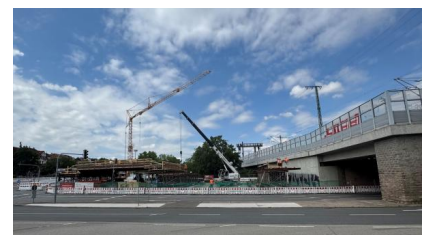
Das zweite Traggerüst für die hunderte Tonnen schweren Teile des neuen Brückenträgers wird errichtet (Juli 2026) [Quelle: DB InfraGO AG/Nina Barthel]
