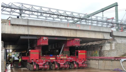
Den alten Brückenträger haben wir ausgefahren. Anschließend wurde er im Kreuzungsbereich zertrümmert und abtransportiert (August 2026) [Quelle: DB InfraGO AG/Alena Grap]
