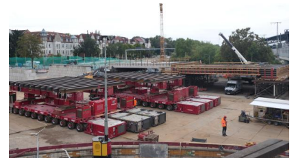
Den alten Brückenträger haben wir ausgefahren. Anschließend wurde er im Kreuzungsbereich zertrümmert und abtransportiert (August 2026) [Quelle: DB InfraGO AG/Alena Grap]
