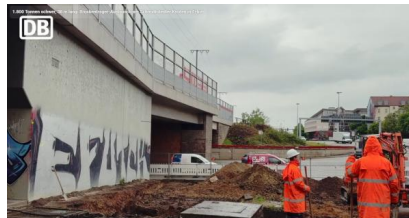
YouTube: 1.800 Tonnen schwer und 38 Meter lang – Austausch eines Brückenträgers am Schmidtstedter Knoten in Erfurt (Mai 2026) [Quelle: DB InfraGO AG]
