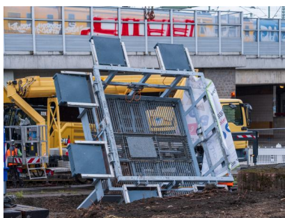
Rückbau eines Lichtmastes zur Baufeldfreimachung (Mai 2026) [Quelle: DB InfraGO AG/Jörn Daberkow]
