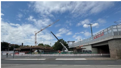
Das zweite Traggerüst für die hunderte Tonnen schweren Teile des neuen Brückenträgers wird errichtet (Juli 2026) [Quelle: DB InfraGO AG/Nina Barthel]
