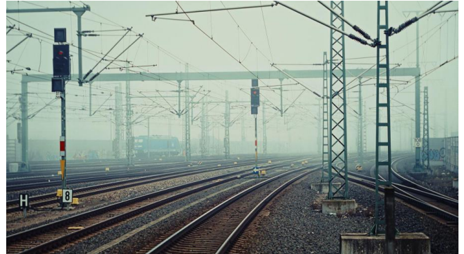
Blick auf die Gleise der Eisenbahnbrücke (März 2026) [Quelle: DB InfraGO AG/Johannes Hurtig]
