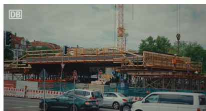
YouTube: Schmidtstedter Knoten Erfurt – Bauleiter Stephan Zeuke zeigt den Baufortschritt (Juli 2026) [Quelle: DB InfraGO AG]
