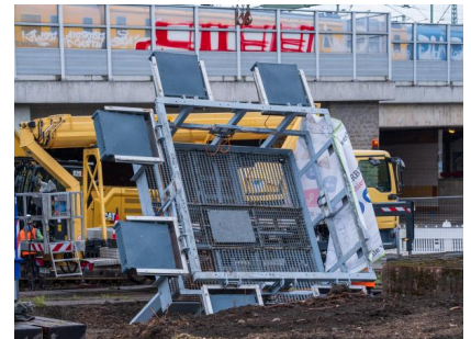
Rückbau eines Lichtmastes zur Baufeldfreimachung (Mai 2026) [Quelle: DB InfraGO AG/Jörn Daberkow]
