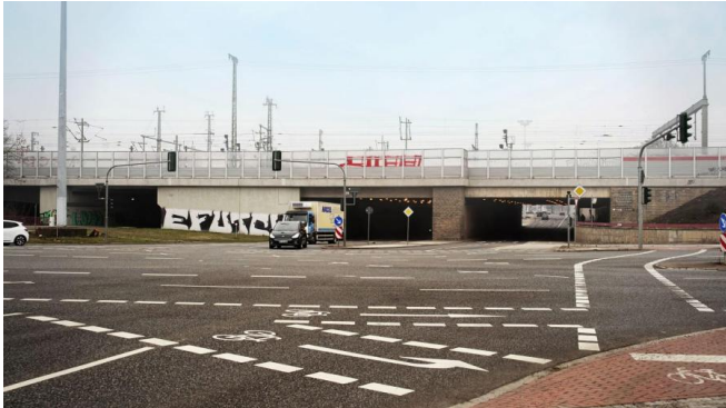
Die Eisenbahnbrücke führt zahlreiche Gleise über den Schmidtstedter Knoten (März 2026) [Quelle: DB InfraGO AG/Johannes Hurtig]
