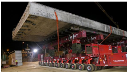
Blick auf das Ausfahren des alten Brückenträgers in den Nachtstunden (August 2026) [Quelle: DB InfraGO AG/Alena Grap]
