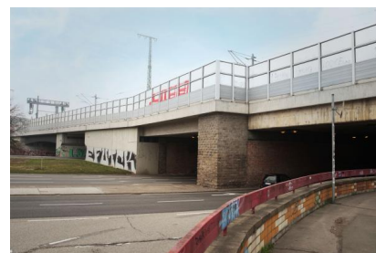
Blick auf die Eisenbahnbrücke am Schmidtstedter Knoten (März 2026) [Quelle: DB InfraGO AG/Johannes Hurtig]
