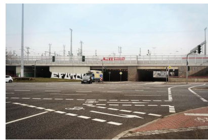
Die Eisenbahnbrücke führt zahlreiche Gleise über den Schmidtstedter Knoten (März 2026) [Quelle: DB InfraGO AG/Johannes Hurtig]
