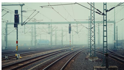
Blick auf die Gleise der Eisenbahnbrücke (März 2026) [Quelle: DB InfraGO AG/Johannes Hurtig]
