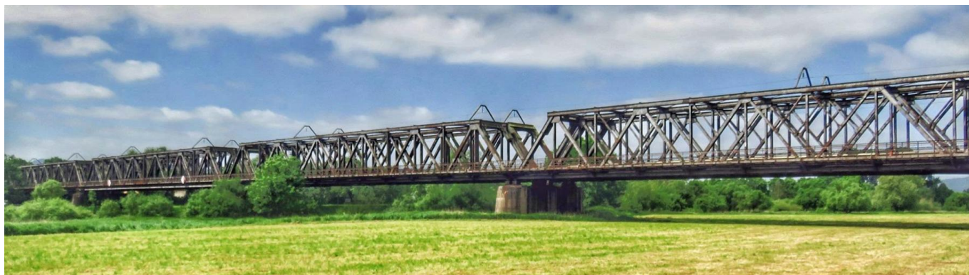
Blick auf die bestehende Eisenbahnüberführung (Mai 2018) [Quelle: DB Netz AG]
