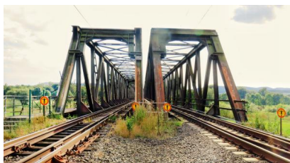
Wir bauen die Eisenbahnüberführung zurück und errichten sie in nördlicher Lage neu (September 2016) [Quelle: DB Netz AG]
