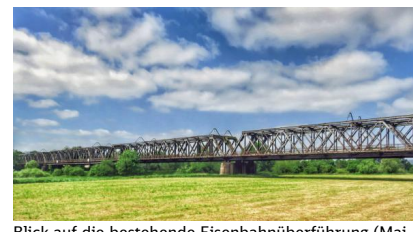
Blick auf die bestehende Eisenbahnüberführung (Mai 2018) [Quelle: DB Netz AG]
