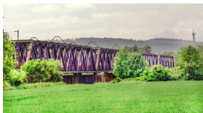
Wir bauen die Eisenbahnüberführung zurück und errichten sie in nördlicher Lage neu (Mai 2018) [Quelle: DB Netz AG]
