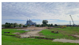
Im Deichvorland entsteht die Baustellenfläche (September 2025) [Quelle: DB InfraGO AG]
