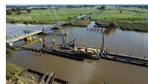
Drohnenaufnahme mit Blick von oben auf die wasserseitigen Arbeiten (September 2025) [Quelle: DB InfraGO AG]
