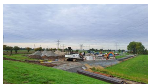
Die Straße „Bardenflether Hellmer“ wurde für die Bauarbeiten angepasst (September 2025) [Quelle: DB InfraGO AG]
