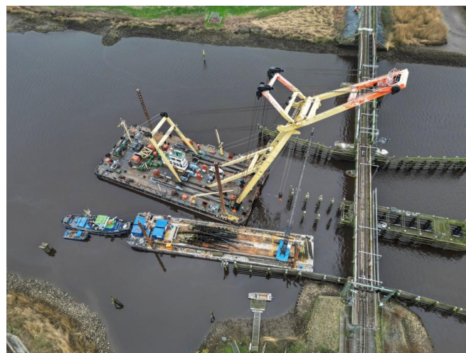
Wir haben das Leitwerk, das Drehteil der Brücke sowie den mittigen Drehpfeiler zurückgebaut und die alte Brücke ausgehoben (März 2024) [Quelle: DB InfraGO AG]
