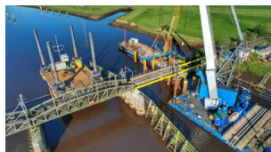
Blick auf den Einhub der Hilfsbrücke (April 2024) [Quelle: DB InfraGO AG]
