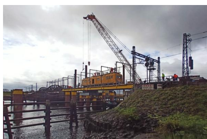
Nach der technischen Abnahme fährt wieder ein Zug über die Brücke (April 2024) [Quelle: Deutsche Bahn AG]
