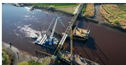
YouTube: Einblick in die Arbeiten für die Hilfsbrücke als provisorische Übergangslösung zur schnellen Wiederaufnahme des Zugverkehrs (Mai 2024) [Quelle: Deutsche Bahn AG]
