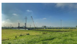
Wir haben an unterschiedlichen Stellen im Wasser Drucksondierungen und Bohrungen durchgeführt (Juni 2024) [Quelle: DB InfraGO AG]
