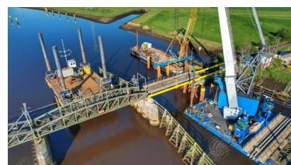
Blick auf den Einhub der Hilfsbrücke (April 2024) [Quelle: DB InfraGO AG]
