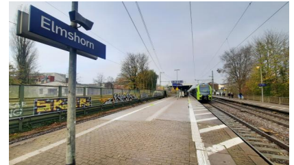
Blick auf den Mittelbahnsteig (November 2022) [Quelle: DB Netz AG]
