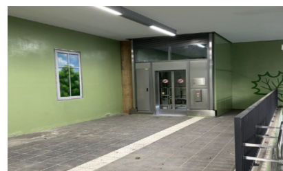
Am 20. Januar 2026 haben wir die Aufzüge am Bahnhof Zeuthen in Betrieb genommen (Januar 2026) [Quelle: DB InfraGO AG]
