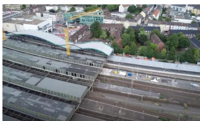
YouTube: Drohnenaufnahme des Baufortschritts (Juli 2023) [Quelle: DB Station&Service AG]
