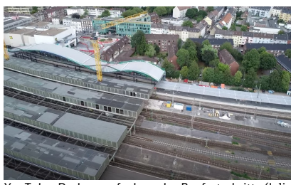
YouTube: Drohnenaufnahme des Baufortschritts (Juli 2023) [Quelle: DB Station&Service AG]
