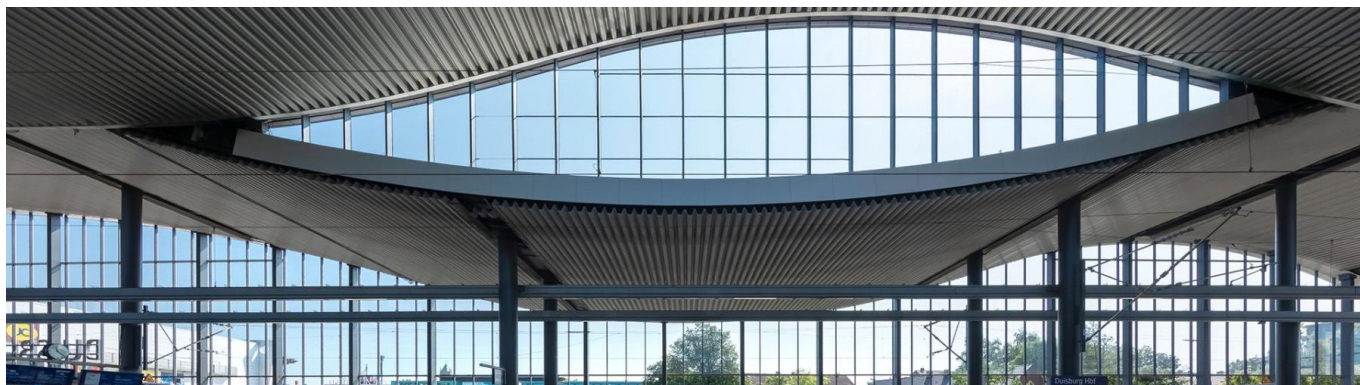
Blick auf die neue wellenförmige Dachstruktur in der Gleishalle. Die gegenläufigen Versätze der Wellenhoch- und Wellentiefpunkte bilden linsenförmige Oberlichter, durch die die ebenfalls neu erstellten Bahnsteige natürlich belichtet werden (August 2024) [Quelle: Deutsche Bahn AG/Axel Hartmann Fotografie]
