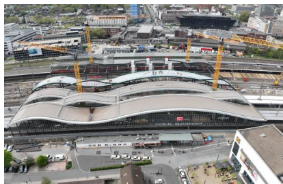
Blick auf den Baufortschritt (April 2025) [Quelle: DB InfraGO AG]
