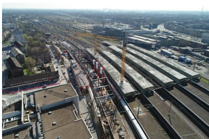
Von August 2022 bis Juli 2023 wurde das neue wellenförmige Dach im Bereich des Bahnsteigs an Gleis 12/13 gebaut (April 2023) [Quelle: DB Station&Service AG]
