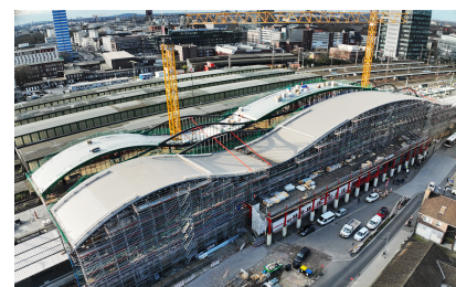
Blick auf den Baufortschritt aus der Vogelperspektive (März 2024) [Quelle: DB InfraGO AG]
