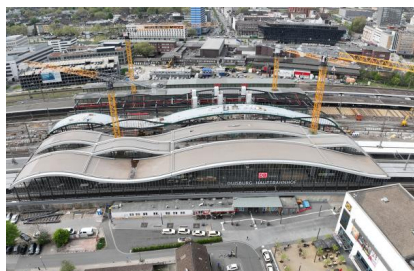
Blick auf den Baufortschritt (April 2025) [Quelle: DB InfraGO AG]
