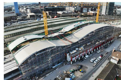
Blick auf den Baufortschritt aus der Vogelperspektive (März 2024) [Quelle: DB InfraGO AG]
