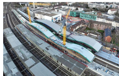
Die Arbeiten am Dach des Bahnsteigs 5 haben wir weitestgehend abgeschlossen (März 2024) [Quelle: DB InfraGO AG]
