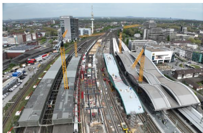
Die Arbeiten am Dach sowie an den Bahnsteigen 3 (Gleise 5/6) und 4 (Gleise 8/9) schreiten voran (April 2025) [Quelle: DB InfraGO AG]
