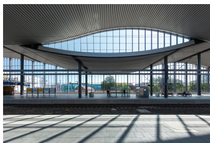
Blick auf die neue wellenförmige Dachstruktur in der Gleishalle. Die gegenläufigen Versätze der Wellenhoch- und Wellentiefpunkte bilden linsenförmige Oberlichter, durch die die ebenfalls neu erstellten Bahnsteige natürlich belichtet werden (August 2024) [Quelle: Deutsche Bahn AG/Axel Hartmann Fotografie]
