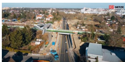
YouTube: Überblick über den Baufortschritt während der Sperrpausen für den Zugverkehr (März 2022) [Quelle: DB Netz AG]
