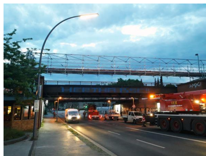
An der Attilastraße wurde im Mai 2019 eine Kabelhilfsbrücke errichtet (Mai 2019) [Quelle: DB Engineering & Consulting]
