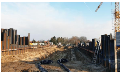
Für die neue Straßenunterführung an der Santissstraße in Berlin finden Aushubarbeiten statt (Dezember 2019) [Quelle: DB Engineering & Consulting]
