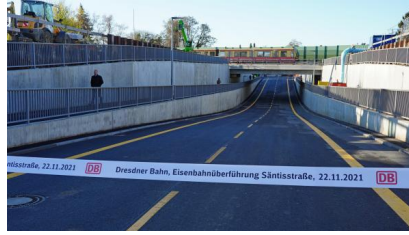
Am 22. November 2021 fand die Eröffnung der Eisenbahnüberführung „Santissstraße“ statt (November 2021) [Quelle: Deutsche Bahn AG/Volker Emersleben]
