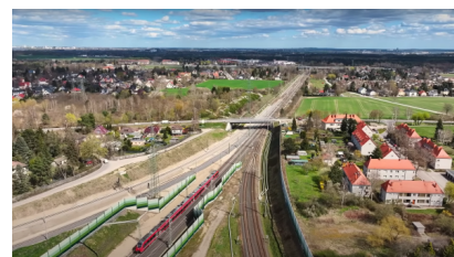
YouTube: Bahntechnische Ausrüstung an der Strecke (Juni 2025) [Quelle: DB InfraGO AG]
