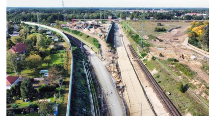
Durch die Verschiebung der beiden Gleise des Berliner Außenrings wurde Platz gewonnen für die beiden Gleise der Mahlower Kurve (rechts). Die Schönefelder Kurve (links) wird eingleisig zurückgebaut (Oktober 2021) [Quelle: DB Netz AG]
