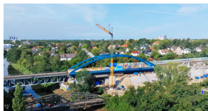
YouTube: Aufbau der Fernbahn an der Attilastraße und dem Teltowkanal (September 2023) [Quelle: DB Netz AG]
