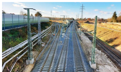
Blick auf die neu verlegten Gleise an der Schönefelder Kurve und dem Berliner Außenring (Blickrichtung Westen) (Dezember 2021) [Quelle: DB Netz AG]
