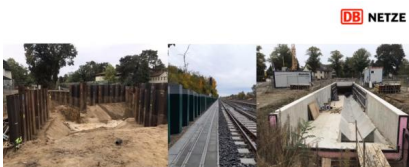
Knoten Berlin, Südkreuz(a) - Blankenfelde (Dresdner Bahn) Bürgerinformation zum aktuellen Stand der Bauausführung
