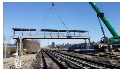
Am 19. März 2018 wurde die provisorisch Fußgängerüberführung am Bahnübergang Sänthisstraße eingehoben [Quelle: DB Netz AG]
