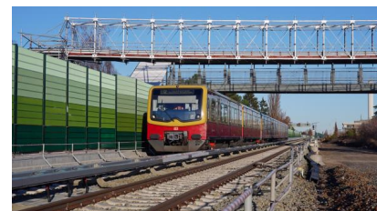
Ein S-Bahnzug überfährt die neue Eisenbahnüberführung „Säntisstraße“ (November 2021) [Quelle: Deutsche Bahn AG/Volker Emersleben]
