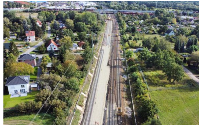
Blick in Richtung Osten auf den Berliner Außenring. Hier wurde die Weichenplatte umgebaut (Oktober 2021) [Quelle: DB Netz AG]
