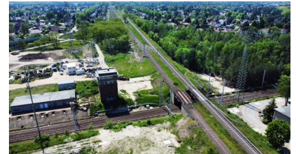
Blick südwärts auf das Kreuzungsbauwerk des Berliner Außenrings. Hier entstehen zwei neue Überbauten für die S-Bahn und die Fernbahn (Juni 2021) [Quelle: DB Netz AG]
