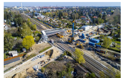
Blick auf die Bauarbeiten an der Santissstraße. Dort entsteht seit April 2019 eine Straßenunterführung (April 2019) [Quelle: DB Netz AG/vectorvision]
