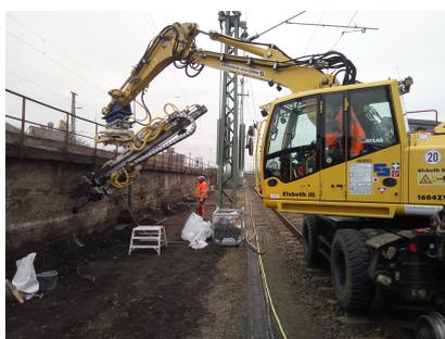
Am Haltepunkt Dresden-Plauen werden Arbeiten zur Stützwandsicherung durchgeführt (November 2020) [Quelle: DB Netz AG]
