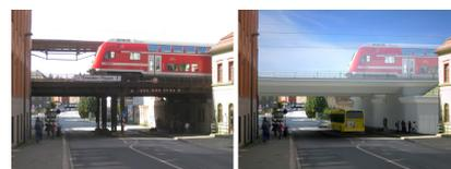
Links: Die Eisenbahnüberführung „Altplauen“ vor dem Umbau, rechts: Visualisierung der neuen Eisenbahnüberführung [Quelle: Deutsche Bahn AG/weitere Bearbeitung INTER OFFICE GmbH]
