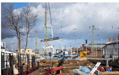
Der Überbau der Eisenbahnüberführung „Würzburger Straße“ wird in seiner finalen Lage aus Fertigteilen montiert (Februar 2022) [Quelle: DB Netz AG/Jörn Daberkow]
