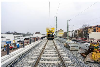
Ein Zweiwege-Oberleitungsmontagefahrzeug unter der Oberleitung des neuen Gleises Dresden – Tharandt (Januar 2023) [Quelle: DB Netz AG/Jörn Daberkow]
