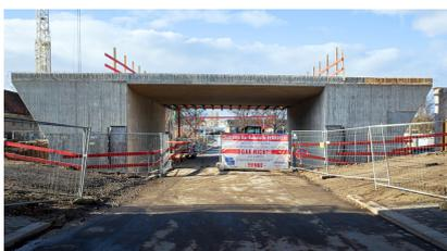
Die Eisenbahnüberführung „Bienertstraße“ wird in Seitenlage zur künftigen Streckenführung hergestellt und zu einem späteren Zeitpunkt hydraulisch in die finale Lage eingeschoben (Februar 2022) [Quelle: DB Netz AG/Jörn Daberkow]
