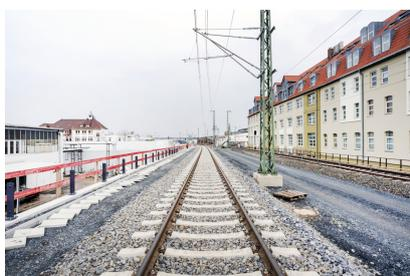
Das erste neue Gleis ist fertiggestellt. Rechts erkennt man neben dem Interimsgleis auch das Planum für das zweite neue Gleis (Januar 2023) [Quelle: DB Netz AG/Jörn Daberkow]
