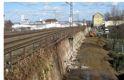
Bis Ende März 2021 finden Arbeiten zur Stützwandsicherung mithilfe sogenannter Schrägpfähle und Horizontalanker statt (Januar 2021) [Quelle: DB Netz AG]
