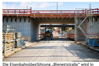
Die Eisenbahnüberführung „Bienertstraße“ wird in Seitenlage zur künftigen Streckenführung hergestellt und zu einem späteren Zeitpunkt hydraulisch in die finale Lage eingeschoben (Februar 2022) [Quelle: DB Netz AG/Jörn Daberkow]
