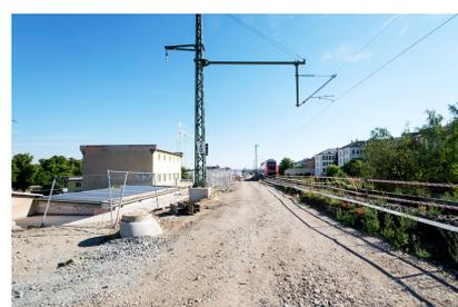
Die Bauarbeiten finden unter „rollendem Rad“ statt. Das bedeutet, dass auf einem Gleis der Zugverkehr weiterhin rollt, während die finale Gleislage errichtet wird (August 2022) [Quelle: DB Netz AG/Jörn Daberkow]
