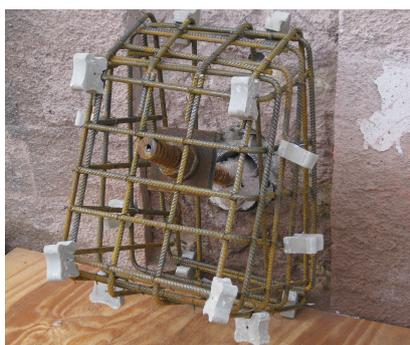
Bis Ende März 2021 finden Arbeiten zur Stützwandsicherung mithilfe sogenannter Schrägpfähle und Horizontalanker statt (Januar 2021) [Quelle: DB Netz AG]
