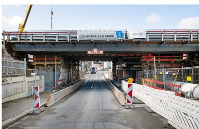
Der Überbau der Eisenbahnüberführung „Würzburger Straße“ wird in seiner finalen Lage aus Fertigteilen montiert werden (Februar 2022) [Quelle: DB Netz AG/Jörn Daberkow]
