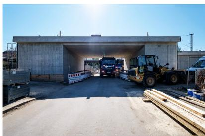
Die Eisenbahnüberführung „Bienertstraße“ wurde in Seitenlage hergestellt und wird voraussichtlich am Mittwoch, 7. September 2022, in die Endlage eingeschoben [Quelle: DB Netz AG/Jörn Daberkow]
