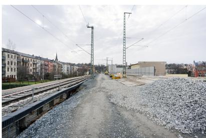
Der Bahndamm auf Höhe Bienertstraße kurz vor der Inbetriebnahme des neuen Gleises Dresden – Tharandt. Links ist das Umfahrgleis zu sehen, rechts erkennt man das neue Gleis (Januar 2023) [Quelle: DB Netz AG/Jörn Daberkow]
