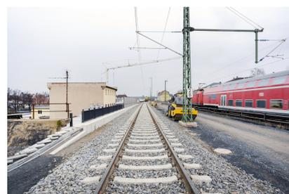
Am neuen Gleis der Fahrtrichtung Dresden – Tharandt wurden bereits erste Lärmschutzwände errichtet (Januar 2023) [Quelle: DB Netz AG/Jörn Daberkow]
