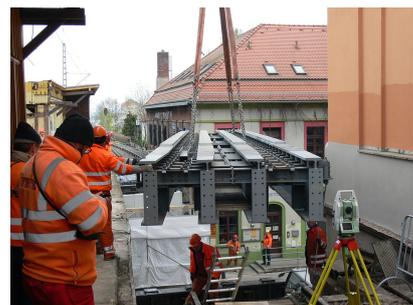
Mit einem Kran wird die Hilfsbrücke in die richtige Position gebracht (April 2019) (2) [Quelle: DB Netz AG]
