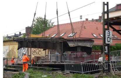
Die alte Brücke wird mithilfe eines Krans von der Unterbaukonstruktion entfernt (Mai 2019) [Quelle: DB Netz AG]
