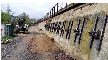
Die Arbeiten zur Stützwandsicherung wurden im Mai 2021 abgeschlossen (Mai 2021) [Quelle: DB Netz AG/Ralf Richter]
