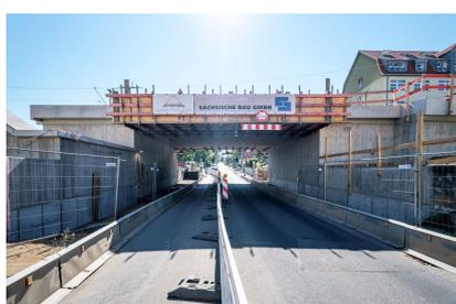
Mitte Januar 2022 wurde der Überbau der Eisenbahnüberführung „Würzburger Straße“ aus Fertigteilen montiert (August 2022) [Quelle: DB Netz AG/Jörn Daberkow]
