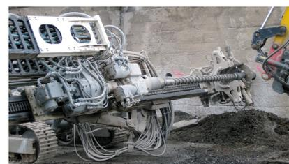
Bis Ende März 2021 finden Arbeiten zur Stützwandsicherung mithilfe sogenannter Schrägpfähle und Horizontalanker statt (Januar 2021) [Quelle: DB Netz AG]
