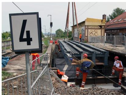
Die Hilfsbrücke schwebt über der Unterbaukonstruktion (Mai 2019) [Quelle: DB Netz AG]
