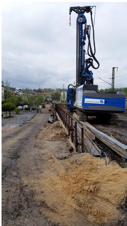
Zur Sicherung des Umfahrgleis muss ein sogenannter Mittenverbau in das Baufeld gerammt werden (Mai 2021) [Quelle: DB Netz AG/Ralf Richter]
