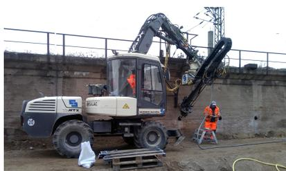
Bis Ende März 2021 finden Arbeiten zur Stützwandsicherung mithilfe sogenannter Schrägpfähle und Horizontalanker statt (Januar 2021) [Quelle: DB Netz AG]
