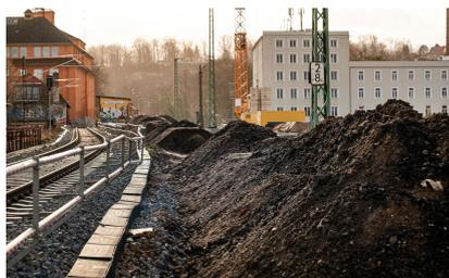
Während die neuen Eisenbahnüberführungen und das erste neue Gleis gebaut werden, kann der Zugverkehr über das Umfahrgleis weiter rollen (Februar 2022) [Quelle: DB Netz AG/Jörn Daberkow]
