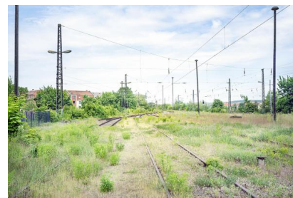
Damit der Bahnhof den Anforderungen des Güterverkehrs entspricht, schaffen wir Platz für neue Wege und deren Beleuchtung. Dafür reduzieren wir die Anzahl der Gleise und erweitern ihre Nutzlänge (Juni 2021) [Quelle: DB Netz AG/Jörn Daberkow]
