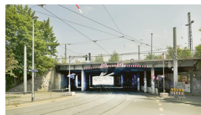
Wir erneuern auch die Eisenbahnbrücke über die Harkortstraße (Juni 2021) [Quelle: DB Netz AG/Jörn Daberkow]
