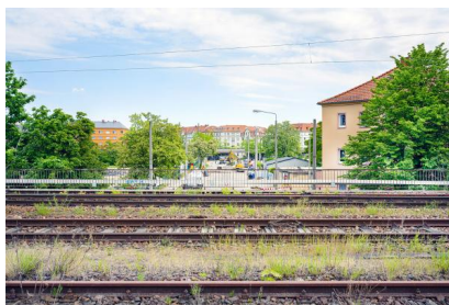
Neben den Arbeiten am Gleisfeld erneuern wir auch die Eisenbahnbrücken „Harkortstraße“ und „Erfurter Straße“ (Juni 2021) [Quelle: DB Netz AG/Jörn Daberkow]
