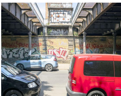
Blick auf die Unterseite der Eisenbahnbrücke über die Erfurter Straße (Juni 2021) [Quelle: DB Netz AG/Jörn Daberkow]
