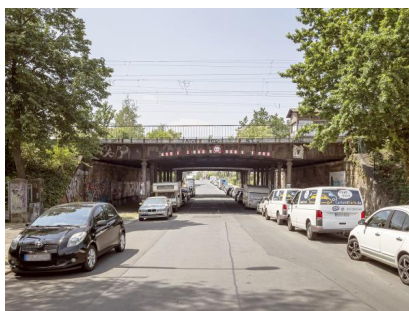
Wir erneuern ebenfalls die Eisenbahnbrücke über die Erfurter Straße (Juni 2021) [Quelle: DB Netz AG/Jörn Daberkow]
