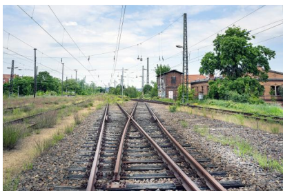
Im Rahmen der Modernisierung bauen wir unter anderem ein neues Elektronisches Stellwerk (Juni 2021) [Quelle: DB Netz AG/Jörn Daberkow]
