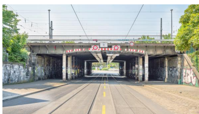
Wir erneuern auch die Eisenbahnbrücke über die Harkortstraße (Juni 2021) [Quelle: DB Netz AG/Jörn Daberkow]
