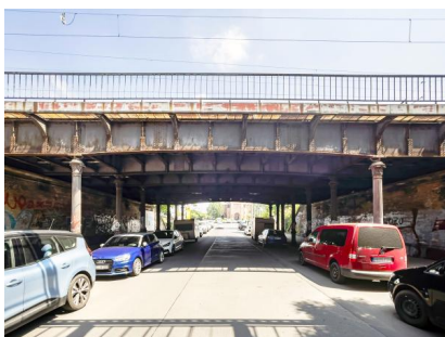
Wir erneuern auch die Eisenbahnbrücke über die Erfurter Straße (Juni 2021) [Quelle: DB Netz AG/Jörn Daberkow]
