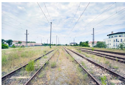
Wir passen den Güterbahnhof an die gestiegenen Anforderungen an (Juni 2021) [Quelle: DB Netz AG/Jörn Daberkow]
