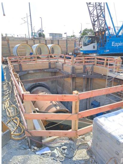
Blick auf die Baugrube für den Rohrvortrieb des Kanals (Juli 2024) [Quelle: DB InfraGO AG/Jannis Steinbicker]
