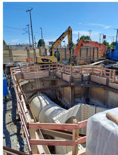
Einbau der Kanalrohre (August 2024) [Quelle: DB InfraGO AG/Jannis Steinbicker]
