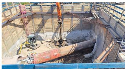
Zielschacht für den Rohrvortrieb mit Provisorium (August 2024) [Quelle: DB InfraGO AG/Jannis Steinbicker]
