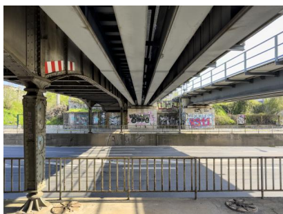
Die Unterseite der Eisenbahnbrücke über die Stauffenbergallee (April 2023) [Quelle: DB InfraGO AG/Jörn Daberkow]
