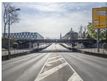
Blick auf die Eisenbahnbrücke über die Stauffenbergallee (April 2023) [Quelle: DB InfraGO AG/Jörn Daberkow]
