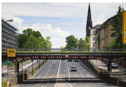
Blick auf die Eisenbahnbrücke über die Stauffenbergallee (April 2021) [Quelle: DB InfraGO AG/Jörn Daberkow]
