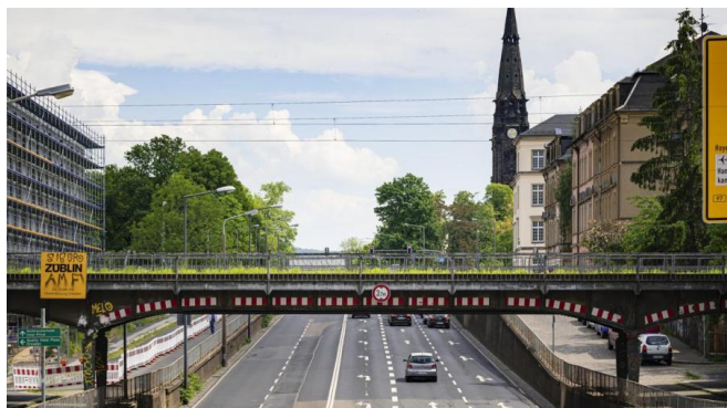
Blick auf die Eisenbahnbrücke über die Stauffenbergallee (April 2021) [Quelle: DB InfraGO AG/Jörn Daberkow]
