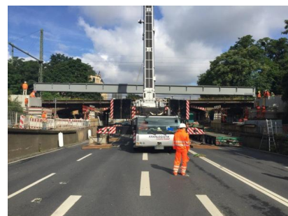
Im Jahr 2016 haben wir bereits zwei alte Überbauten der Brücke durch Hilfsbrücken ersetzt (2016) [Quelle: Deutsche Bahn AG/Jens Tusche]
