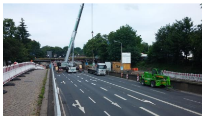
Im Jahr 2016 haben wir bereits zwei alte Überbauten der Brücke durch Hilfsbrücken ersetzt (2016) [Quelle: Deutsche Bahn AG/Jens Tusche]
