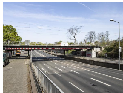
Blick auf die Eisenbahnbrücke über die Stauffenbergallee (April 2023) [Quelle: DB InfraGO AG/Jörn Daberkow]
