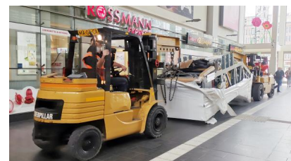
Die neuen Fahrtreppen für den Bahnsteig 7 am Hauptbahnhof Dortmund werden an ihren finalen Standort transportiert (Mai 2020) [Quelle: DB Engineering & Consulting GmbH]
