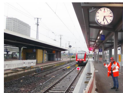
Nachdem der Bahnsteig 7 am Hauptbahnhof Dortmund fertiggestellt wurde, folgte am 1. Juli 2020 die erste Zugfahrt am Gleis 21 (Juli 2020) [Quelle: DB Engineering & Consulting GmbH]
