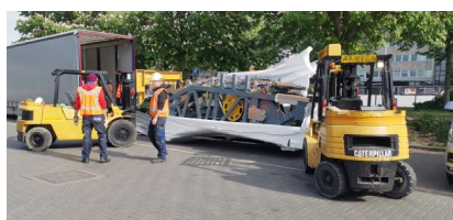
Die neuen Fahrtreppen für den Bahnsteig 7 am Hauptbahnhof Dortmund werden angeliefert (Mai 2020) [Quelle: DB Engineering & Consulting GmbH]
