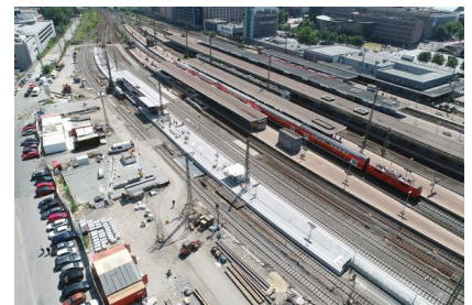
Blick auf das Baugeschehen am Dortmunder Hauptbahnhof (Juli 2019) (4) [Quelle: DB Station&Service AG]
