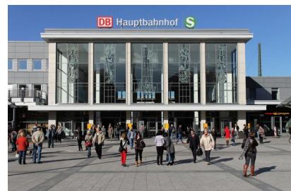
Das Empfangsgebäude des Dortmunder Hauptbahnhofs im neuen Antlitz nach der Renovierung 2011 [Quelle: Deutsche Bahn AG/Wolfgang Klee]
