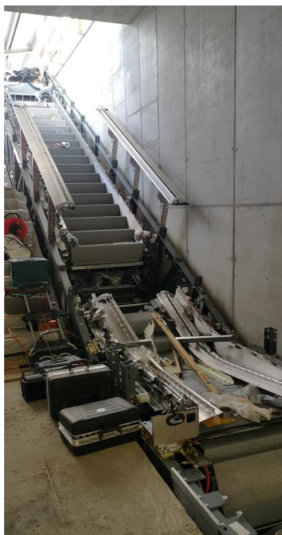
Die neuen Fahrtreppen für den Bahnsteig 7 am Hauptbahnhof Dortmund werden eingebaut (Mai 2020) (1) [Quelle: DB Engineering & Consulting GmbH]
