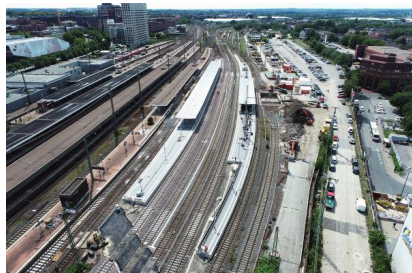
Blick auf das Baufeld am Dortmunder Hauptbahnhof aus der Vogelperspektive (Juli 2020) [Quelle: DB Engineering & Consulting GmbH]
