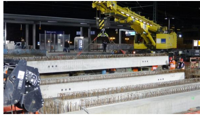
In der Nacht 16./17. März 2020 wurden vier Fertigbalken für die Bahnsteigbrücke am Bahnsteig 7 eingehoben (4) [Quelle: DB Station&Service AG]
