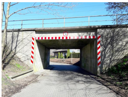
Das Projekt umfasst die Modernisierung weiterer kleinerer Bahnbrücken, wie die der Eisenbahnüberführung „Listweg“. Hier werden die Umbauarbeiten von 2026 bis 2028 durchgeführt (April 2018) [Quelle: DB Netz AG/Raffaela Cannizzo]
