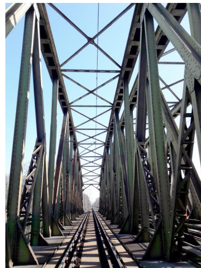
Aufgrund des Brückenumbaus wird auch die Oberleitungsanlage angepasst, damit der Damm um 1,4 Meter aufgeschüttet werden kann (April 2018) [Quelle: DB Netz AG/Raffaela Cannizzo]
