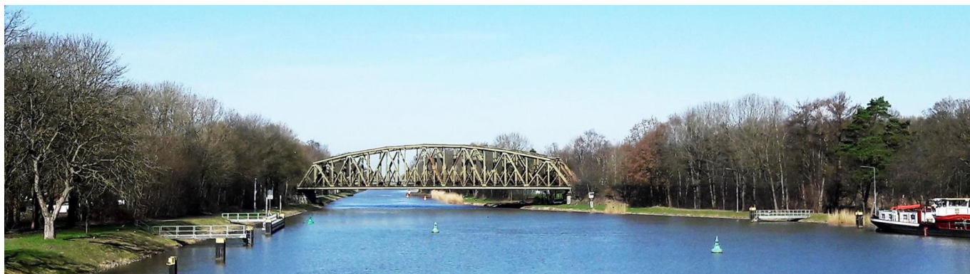
Die Eisenbahnüberführung über den Dortmund-Ems-Kanal muss erneuert werden. Hierbei wird außerdem die Durchfahrtshöhe für Schiffe um 1,4 Meter vergrößert (April 2018) [Quelle: DB Netz AG/Raffaella Cannizzo]
