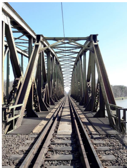
Bevor die Brücke erneuert wird (hier: Blickrichtung Hörstel), wird zunächst die Schleuse des Dortmund-Ems-Kanals erneuert (April 2018) [Quelle: DB Netz AG/Raffaela Cannizzo]
