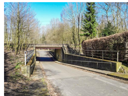
Auch die Eisenbahnüberführung „Zur Helle“ wird im Rahmen des Umbaus erneuert. Als Zeitraum hierfür ist 2027/2028 vorgesehen (April 2018) [Quelle: DB Netz AG/Raffaela Cannizzo]
