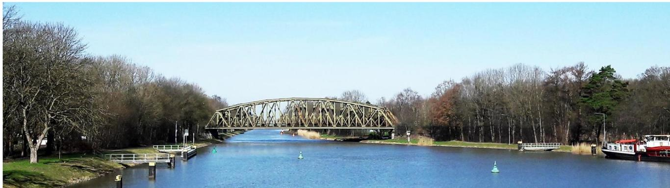
Die Eisenbahnüberführung über den Dortmund-Ems-Kanal muss erneuert werden. Hierbei wird außerdem die Durchfahrtshöhe für Schiffe um 1,4 Meter vergrößert (April 2018)
