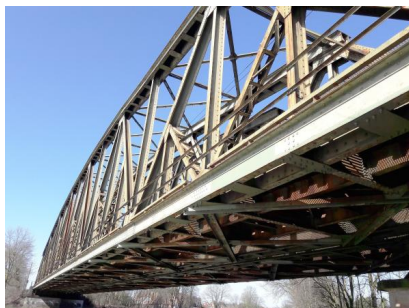
Ansicht der Unterkonstruktion der bestehenden Fachwerkbrücke. Im Hintergrund ist eines der beiden Betonwiderlager zu sehen (April 2018) [Quelle: DB Netz AG/Raffaela Cannizzo]
