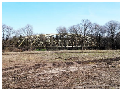
Es ist vorgesehen, die Fachwerküberbauten der bestehenden Brücke herauszuheben und über den Wasserweg abzutransportieren. Während der Arbeiten bleibt – bis auf kurzzeitige Ausnahmen – jeweils ein Gleis in Betrieb, um den Bahnverkehr weiterhin zu ermöglichen (April 2018) [Quelle: DB Netz AG/Raffaela Cannizzo]
