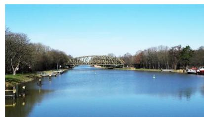
Die Eisenbahnüberführung über den Dortmund-Ems-Kanal muss erneuert werden. Hierbei wird außerdem die Durchfahrtshöhe für Schiffe um 1,4 Meter vergrößert (April 2018) [Quelle: DB Netz AG/Raffaela Cannizzo]
