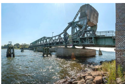
Die geschlossene Klappbrücke von der Ostseite [Quelle: Bärbel Koppe]
