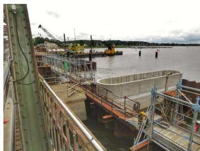
Wir haben den Rohbau des Pfeilers 1 fertiggestellt (November 2023) [Quelle: DB Netz AG]
