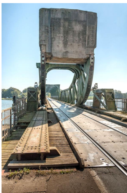
Die bestehende Brücke wird gleichermaßen vom Eisenbahn- und Straßenverkehr sowie Fußgänger:innen und Radfahrern genutzt [Quelle: Bärbel Koppe]
