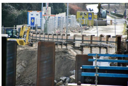
An der Schleibrücke Lindaunis wird sowohl vom Land als auch vom Wasser aus gearbeitet (März 2021) [Quelle: Deutsche Bahn AG]
