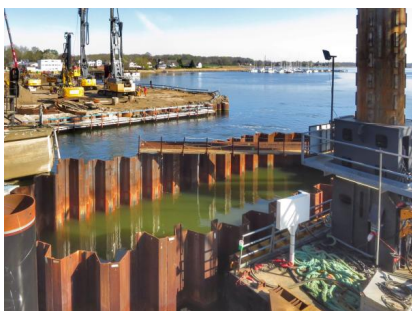
Blick auf die Vorbereitungsarbeiten für die Aussteifung der Baugrube von Pfeiler 3 (April 2022) [Quelle: DB Netz AG]
