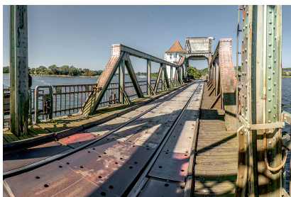
Die alte Brücke hat eine Straßenfahrbreite von 2,8 Metern und besitzt Notgehwege mit einer Breite von je 0,6 Metern [Quelle: Bärbel Koppe]
