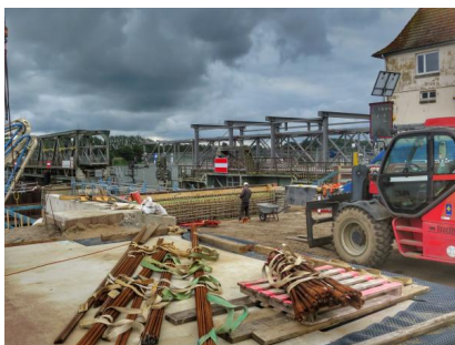
Die Bewehrung des Widerlagers Nord (Juni 2024) [Quelle: DB InfraGO AG]
