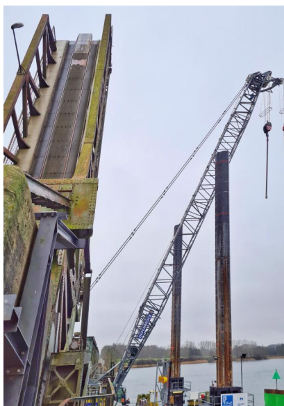
Herstellung der Dalben (Januar 2022) [Quelle: DB Netz AG]
