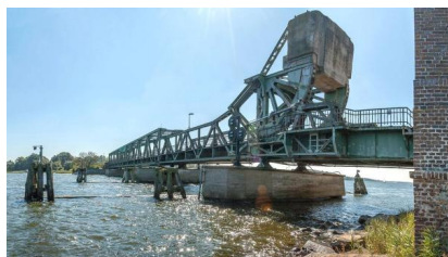
Die geschlossene Klappbrücke von der Ostseite [Quelle: Bärbel Koppe]
