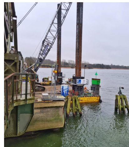
Herstellung der Dalben (Januar 2022) [Quelle: DB Netz AG]
