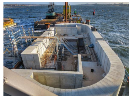
Der Pfeiler 3 wurde so weit fertiggestellt, dass er für die Arbeiten am Stahlüberbau bereit ist (Februar 2025) [Quelle: DB InfraGO AG/Lars Kalweit]
