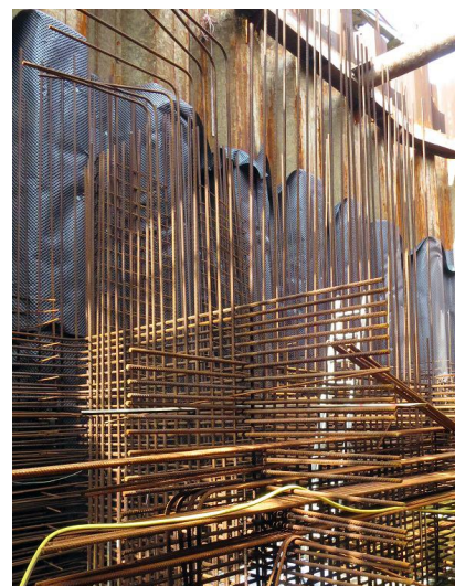
Die Bewehrung des Pfeilers 3 (Juli 2023) [Quelle: DB Netz AG/Lars Kalweit]
