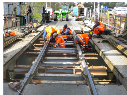
Wir führen die jährlichen Inspektions- und Instandhaltungsarbeiten durch (April 2022) [Quelle: DB Netz AG]
