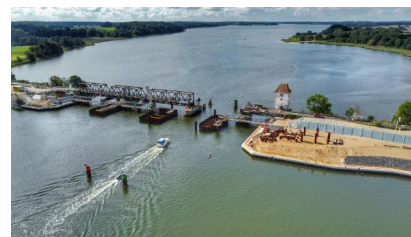
Luftaufnahme der Brücke (2023) [Quelle: Arge KrBW Lindaunis]
