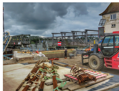
Die Bewehrung des Widerlagers Nord (Juni 2024) [Quelle: DB InfraGO AG]
