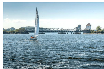
Zwischen den Stationen Rieseby und Süderbrarup kreuzt die Brücke die Wasserstraße Schlei [Quelle: Bärbel Koppe]
