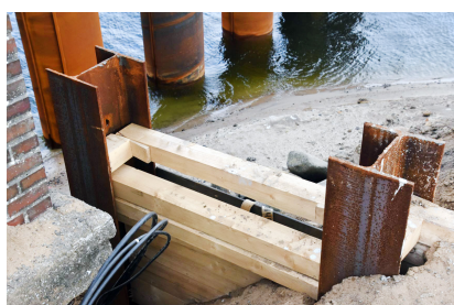
Zwischen die bestehenden Brückenpfeiler auf der Südseite wurden sogenannte Hilfsabfangungen gebaut (März 2021) [Quelle: Deutsche Bahn AG]
