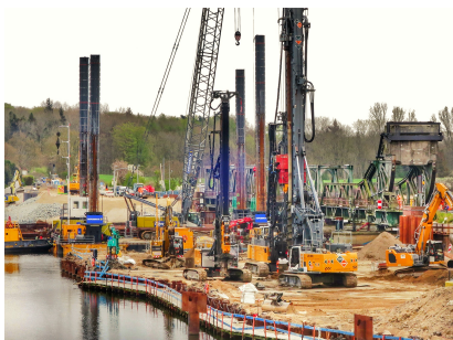
Blick auf die Herstellung der geotextilmantelten Sandsäulen, die Vorbereitungsarbeiten für die Aussteifung der Baugrube von Pfeiler 3 sowie auf die Deckwerksherstellung vom Damm Süd (April 2022) [Quelle: DB Netz AG]
