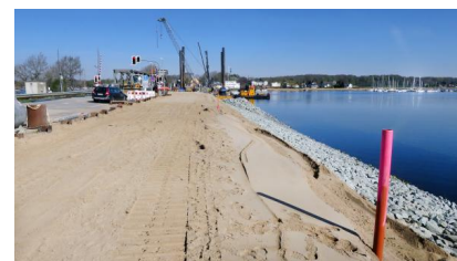
Der Damm Süd mit Messpegel wird hergestellt (April 2022) [Quelle: DB Netz AG]
