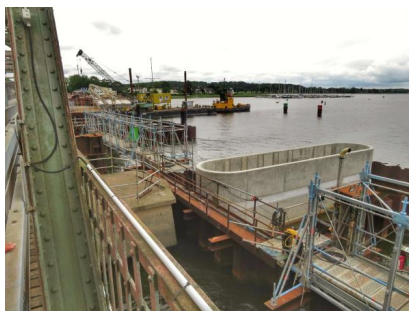
Wir haben den Rohbau des Pfeilers 1 fertiggestellt (November 2023) [Quelle: DB Netz AG]
