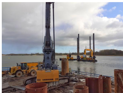
Gründungsarbeiten auf der Nordseite und Hubinsel mit Bagger auf der Schlei (Februar 2022) [Quelle: DB Netz AG]
