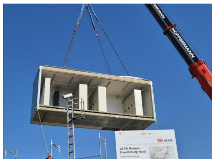
Am 25. Juni 2024 haben wir das Modulgebäude für das Elektronische Stellwerk in Bremen-Burg aufgestellt (Juni 2024) [Quelle: DB InfraGO AG]
