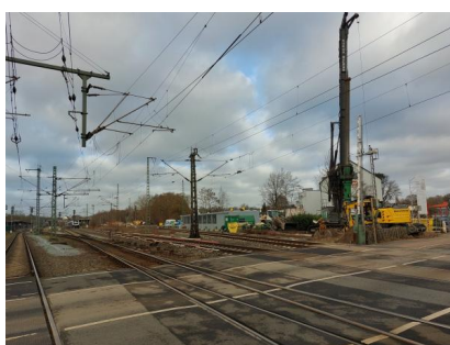
Am 23. Januar 2024 haben wir den Bediencontainer in Bremen-Burg aufgestellt (Januar 2024) [Quelle: DB InfraGO AG]
