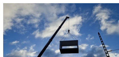
Am 23. Januar 2024 haben wir den Bediencontainer in Bremen-Burg aufgestellt (Januar 2024) [Quelle: DB InfraGO AG]
