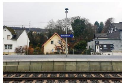
Der Mittelbahnsteig wurde mit einer Höhe von 76 Zentimetern über Schienenoberkante neu gebaut (Januar 2022) [Quelle: DB Station&Service AG]
