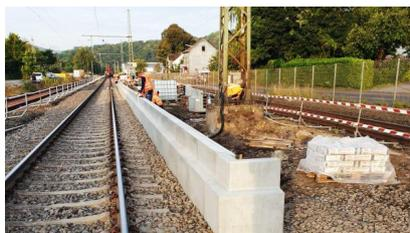
Der Mittelbahnsteig wird mit einer Höhe von 76 Zentimetern über Schienenoberkante neu gebaut (September 2021) [Quelle: DB Station&Service AG]
