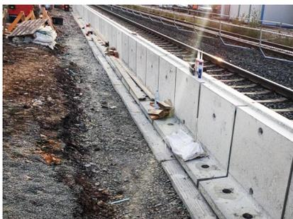
Der Mittelbahnsteig wird mit einer Höhe von 76 Zentimetern über Schienenoberkante neu gebaut (September 2021) [Quelle: DB Station&Service AG]
