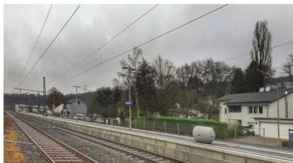
Der Mittelbahnsteig wurde mit einer Höhe von 76 Zentimetern über Schienenoberkante neu gebaut (Januar 2022) [Quelle: DB Station&Service AG]
