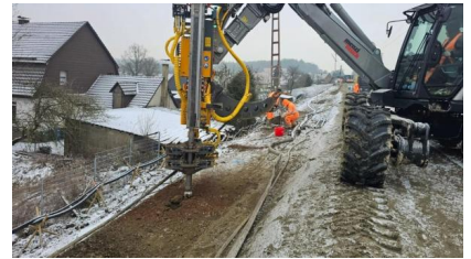
Bahndammsanierung im Bereich des Ostgleises (Oktober 2024) [Quelle: Detlev Zache]
