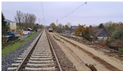
Bahndammsanierung im Bereich des Ostgleises (November 2024) [Quelle: Detlev Zache]
