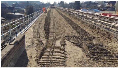
Bahndammsanierung im Bereich des Ostgleises (März 2025) [Quelle: Detlev Zache]
