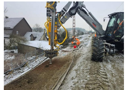
Bahndammsanierung im Bereich des Ostgleises (Oktober 2024) [Quelle: Detlev Zache]
