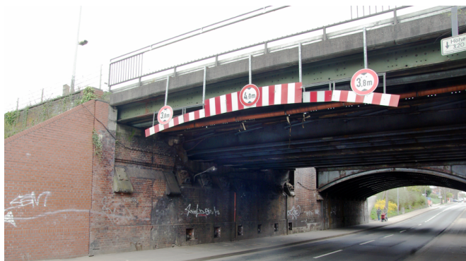
Die Eisenbahnbrücke „Bleckeder Landstraße“ in Lüneburg wird erneuert (Dezember 2020) [Quelle: DB Netz AG]
