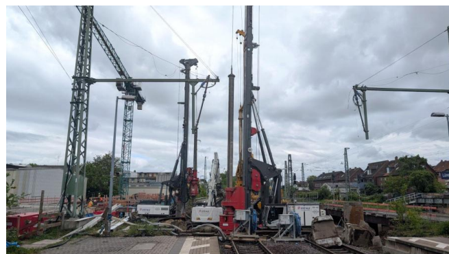
Blick vom Hausbahnsteig auf die Baustelle. Auf der Strecke zwischen Hamburg und Hannover finden wichtige Arbeiten für die neue Brücke statt (Mai 2026) [Quelle: DB InfraGO AG]
