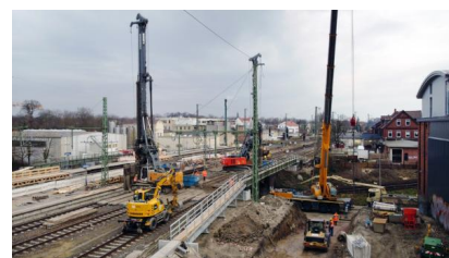
Um die Eisenbahnbrücke „Bleckeder Landstraße“ in Lüneburg zu erneuern, wurden vorbereitend 30 Bohrpfähle in den Boden eingebracht (März 2021) [Quelle: DB Netz AG]
