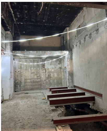
Blick auf den Baufortschritt im Bauabschnitt 2 (Februar 2026) [Quelle: DB InfraGO AG]
