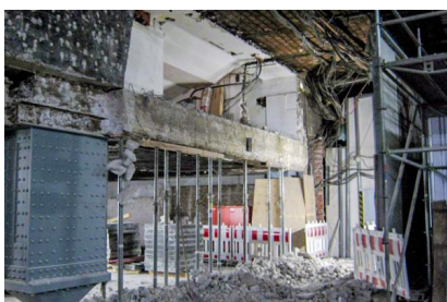
Weitere Teile der Erdgeschossflächen werden zurückgebaut (Januar 2019) [Quelle: DB Station&Service AG]
