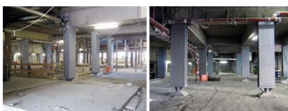
Die Abbrucharbeiten im Erdgeschoss schreiten voran (September 2017) [Quelle: DB Station&Service AG]
