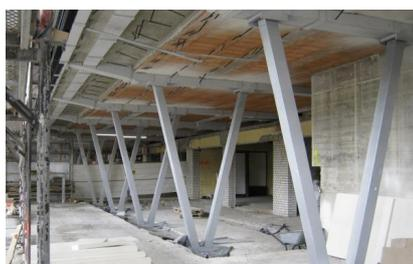
Die sogenannten V-Stützen stabilisieren das Dach der Zooterrassen (Mai 2016) [Quelle: DB Station&Service AG]
