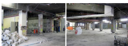
Im Rahmen der Arbeiten für den Bauabschnitt 2 wurde das Erdgeschoss bis auf tragende und statisch relevante Elemente entkernt (April 2017) [Quelle: DB Station&Service AG]
