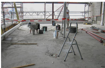
Arbeiten an der Außenterrasse am Bahnhof Zoologischer Garten (Mai 2016) [Quelle: DB Station&Service AG]
