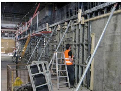
Die Wände im Erdgeschoss werden betoniert (Mai 2018) [Quelle: DB Station&Service AG]
