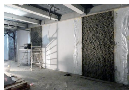
Die Bauarbeiten in der Fernbahnhalle des Bahnhofs Berlin Zoologischer Garten schreiten voran (September 2019) (2) [Quelle: DB Station&Service AG]
