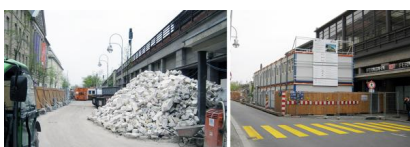
Die Baustelle für den Bauabschnitt 2 wurde eingerichtet (April 2017) [Quelle: DB Station&Service AG]
