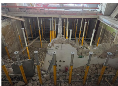
Baufortschritt im Empfangsgebäude in der S-Bahn-Halle im Bauabschnitt 2 (September 2025) [Quelle: DB InfraGO AG]
