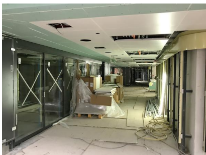
Derzeit finden Arbeiten an den Erdgeschossflächen im Empfangsgebäude statt (Juli 2020) (2) [Quelle: DB Station&Service AG]
