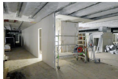
Im Erdgeschoss des Bahnhofs Berlin Zoologischer Garten werden die Trockenbauwände errichtet (September 2019) [Quelle: DB Station&Service AG]
