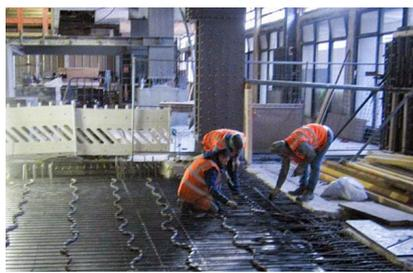
Schal- und Bewehrungsarbeiten an der Decke des Kellergeschosses (März 2019) [Quelle: DB Station&Service AG]
