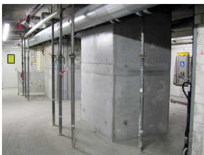
Im Untergeschoss werden Betonierungsarbeiten durchgeführt (Mai 2018) [Quelle: DB Station&Service AG]
