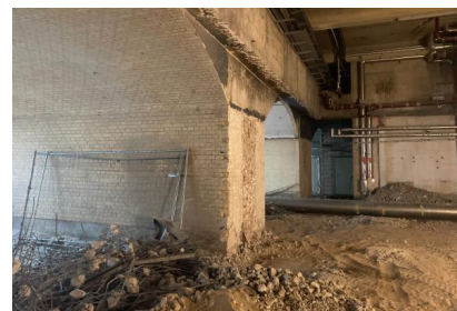
Die Flächen der Bundespolizei im Bauabschnitt 3 (Januar 2026) [Quelle: DB InfraGO AG]
