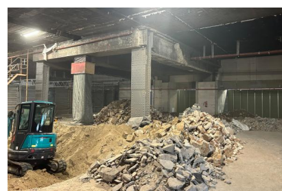
Baufortschritt im Empfangsgebäude in der S-Bahn-Halle im Bauabschnitt 2 (November 2025) [Quelle: DB InfraGO AG]
