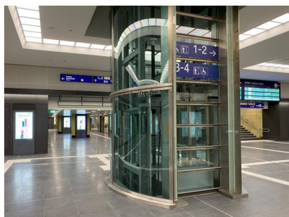
Die Haupthalle des Bahnhofs wurde umfangreich modernisiert. Dabei wurden auch technische Anlagen wie die Aufzüge erneuert (Februar 2021) [Quelle: DB Station&Service AG]
