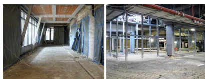
Links: Die Shop-Fassade in Richtung Hardenbergplatz wird saniert, rechts: Die alten Rolltreppen, die zu den Bahnsteigen führten, wurden bereits zurückgebaut (September 2017) [Quelle: DB Station&Service AG]
