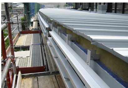
Arbeiten am Dach der modernisierten Zooterrassen (Mai 2016) [Quelle: DB Station&Service AG]
