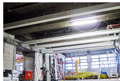
Die Stahlträger im Erdgeschoss werden montiert (März 2019) [Quelle: DB Station&Service AG]
