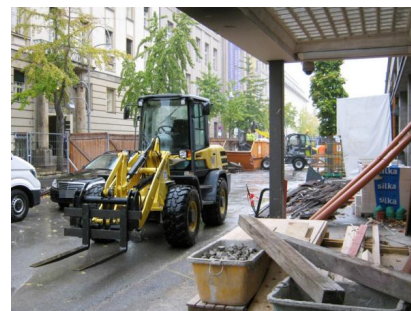
Blick auf die Baustellen-Einrichtungsfläche (Oktober 2018) [Quelle: DB Station&Service AG]
