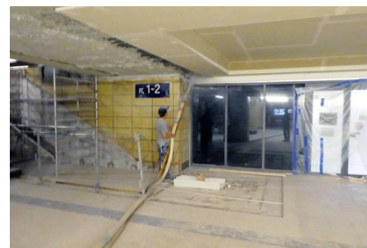
Im Zwischengeschoss des Bahnhofs Berlin Zoologischer Garten wird der Branschutzputz angebracht (September 2019) [Quelle: DB Station&Service AG]
