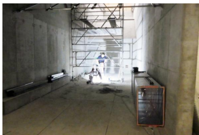
An dieser Stelle entsteht im Bahnhof Berlin Zoologischer Garten eine Fahrtreppe (September 2019) [Quelle: DB Station&Service AG]
