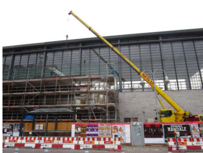
Die Bauarbeiten am Bahnhof Berlin Zoologischer Garten schreiten voran (November 2015) [Quelle: DB Station&Service AG]
