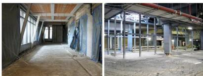
Links: Die Shop-Fassade in Richtung Hardenbergplatz wird saniert, rechts: Die alten Rolltreppen, die zu den Bahnsteigen führten, wurden bereits zurückgebaut (September 2017) [Quelle: DB Station&Service AG]
