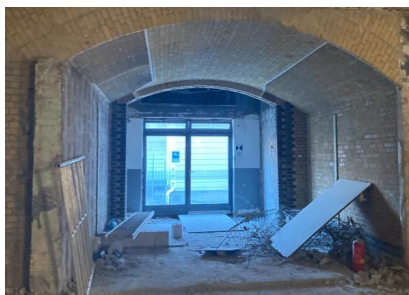
Die Flächen der Bundespolizei im Bauabschnitt 3 (Januar 2026) [Quelle: DB InfraGO AG]
