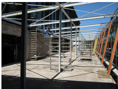
Arbeiten am Bahnhof Berlin Zoologischer Garten (1) (Sommer 2015) [Quelle: DB Station&Service AG]
