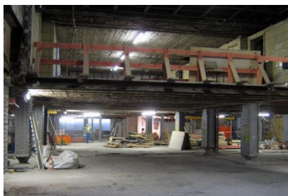
Das Erdgeschoss wird entkernt (Oktober 2018) [Quelle: DB Station&Service AG]
