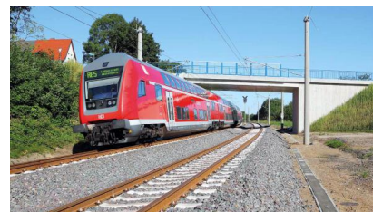
Nach Abschluss der Bauarbeiten sind zwischen Berlin und Rostock kürzere Reisezeiten möglich [Quelle: Deutsche Bahn AG]
