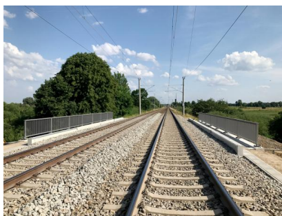
Die Arbeiten an der Eisenbahnüberführung „Wesenberger Chaussee“ in Neustrelitz wurden im Juni 2021 abgeschlossen (Juni 2021) [Quelle: DB Netz AG]
