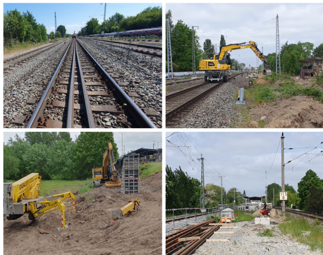
Unter anderem führen wir Gleisarbeiten durch. Außerdem finden Betonier- und Nacharbeiten zu den Rammarbeiten rund um die Oberleitungsanlage statt (Mai 2023) [Quelle: DB Netz AG]
