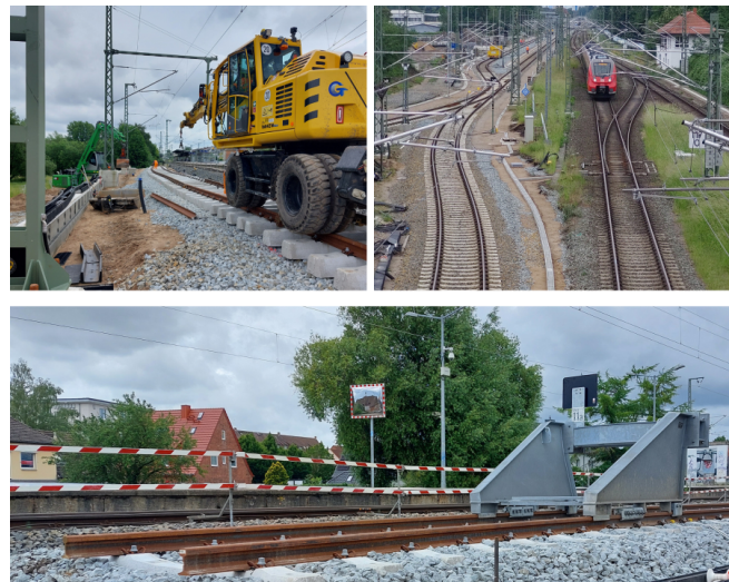
Blick auf den Fortschritt bei den Gleisbauarbeiten (Juli 2024) [Quelle: DB InfraGO AG]
