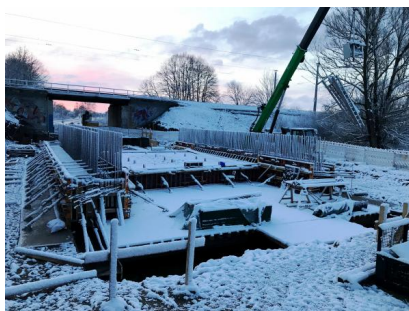
In Neustrelitz fanden Arbeiten zur Erneuerung der Eisenbahnüberführung „Wesenberger Chaussee“ statt (April 2021) [Quelle: DB Netz AG]
