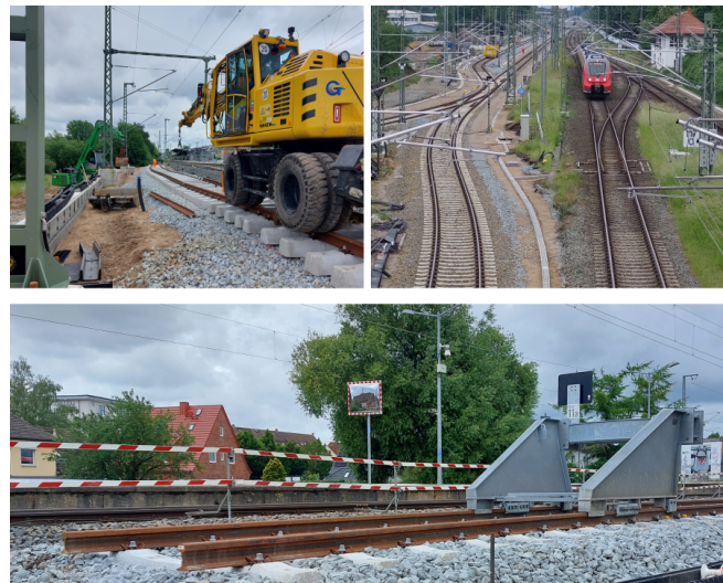
Blick auf den Fortschritt bei den Gleisbauarbeiten (Juli 2024) [Quelle: DB InfraGO AG]
