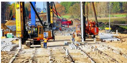
Einbringung von Ramppfählen im Abschnitt Nassenheide - Löwenberg [Quelle: Deutsche Bahn AG]
