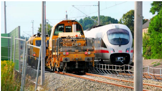
Die Strecke zwischen Berlin und Rostock wird für höhere Geschwindigkeiten bis 160 km/h ausgerüstet [Quelle: Deutsche Bahn AG]
