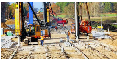
Einbringung von Ramppfähle im Abschnitt Nassenheide - Löwenberg [Quelle: Deutsche Bahn AG]
