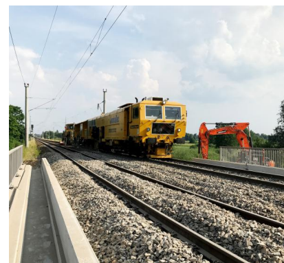
An der Eisenbahnüberführung „Wesenberger Chaussee“ in Neustrelitz wurden Schotterarbeiten durchgeführt (Juni 2021) [Quelle: DB Netz AG]
