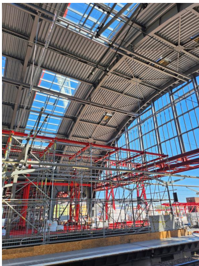
Die Gleishallendächer werden erneuert (Mai 2023) [Quelle: DB Station&Service AG]
