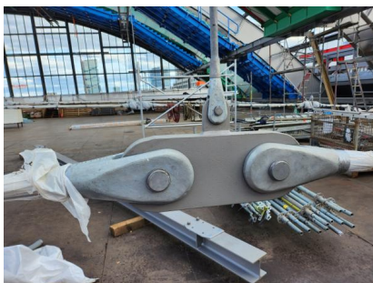
Der Augenanschluss eines Zugbands (2024) [Quelle: DB Engineering & Consulting GmbH/Marius Müller]
