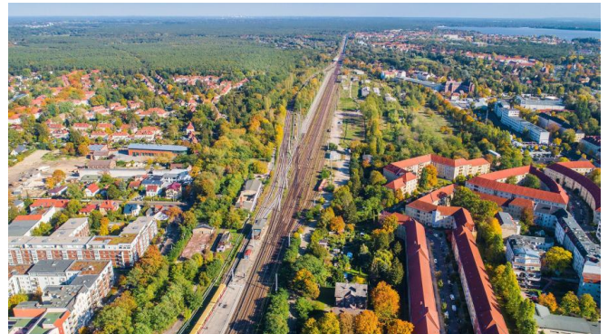
Blick auf die östlich vom Bahnhof Köpenick gelegenen Gleise (Januar 2023) [Quelle: DB Netz AG/VECTORVISION GmbH]
