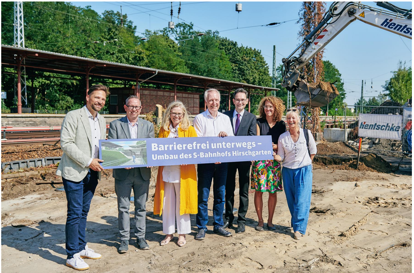
Am 6. September 2024 fand der Spatenstich für den Umbau des S-Bahnhofs Hirschgarten statt. Mit dabei waren Maik Penn (Mitglied im Abgeordnetenhaus von Berlin), Oliver Igel (Bezirksbürgermeister Treptow-Köpenick), Ute Bonde (Senatorin für Mobilität, Verkehr, Klimaschutz und Umwelt), Alexander Kaczmarek (Konzernbevollmächtigter der Deutschen Bahn für Berlin, Brandenburg und Mecklenburg-Vorpommern), Frank Engel (Referatsleiter Finanzen in der Region Nord im Bundesministerium für Digitales und Verkehr), Dr. Claudia Leistner (Bezirksstadträtin für Straßen, Grünflächen, Umwelt und Naturschutz in Treptow-Köpenick), Dunja Wolff (Mitglied im Abgeordnetenhaus von Berlin) (v. l. n. r.) (September 2024) [Quelle: Deutsche Bahn AG/ Dominic Dupont]
