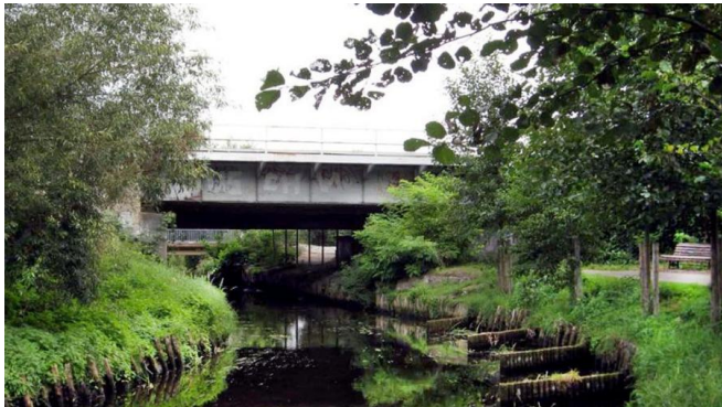
Die Eisenbahnüberführung (EÜ) „Neuhagener Mühlenfließ“ wurde modernisiert [Quelle: DB Netz AG]
